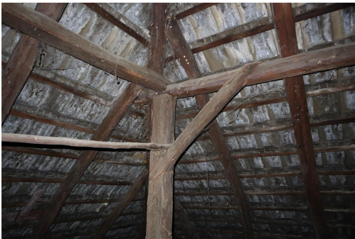
Detail uloženia stĺpika drážkovým čapom.
