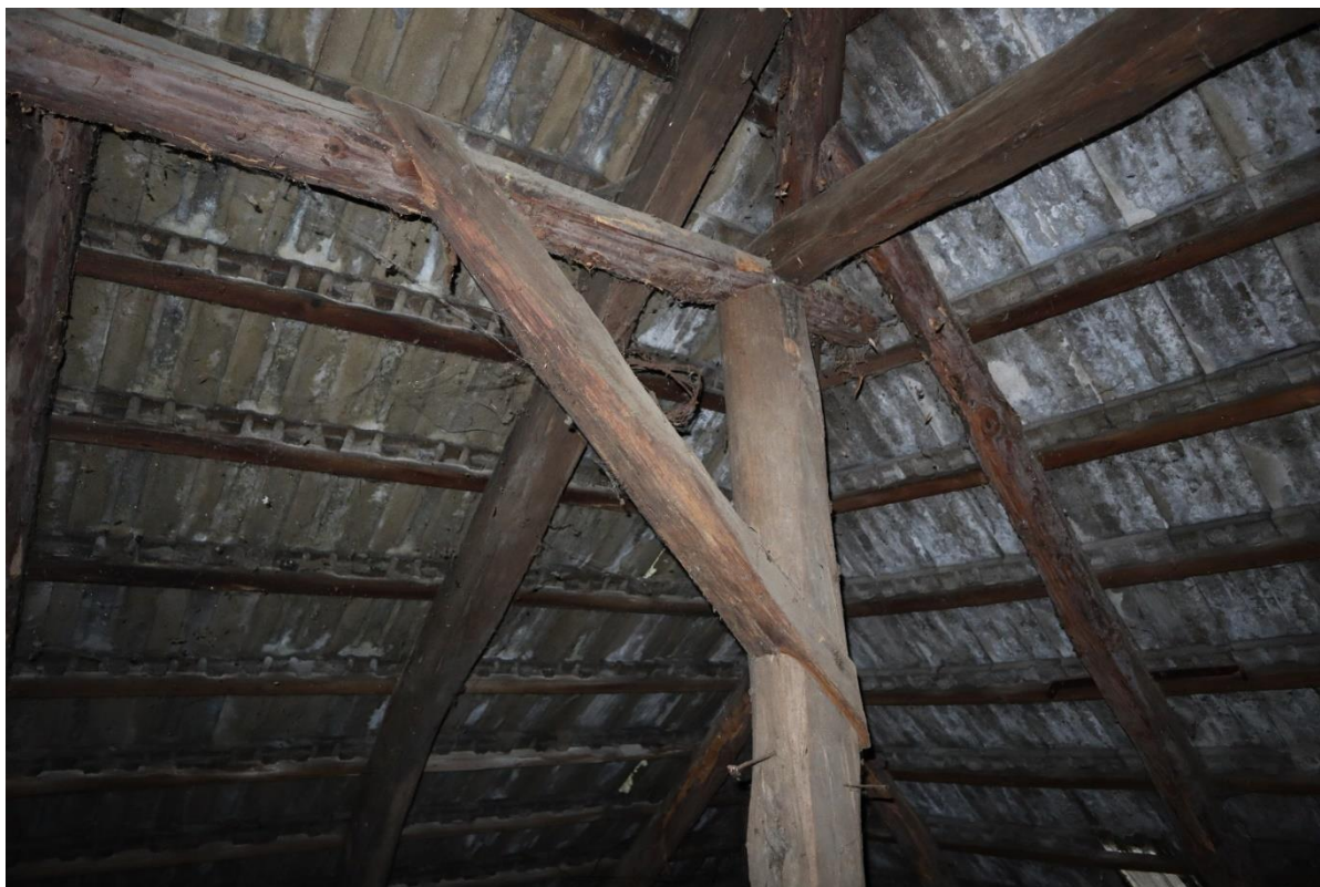
Detail napojenia stĺpu na stredovú väznicu lipnutím.
