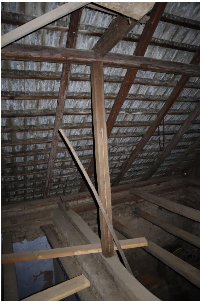
Detail uloženia stĺpika na väzný trám. Spojenie väzného trámu s pomúrnicou kovovou sponou.
