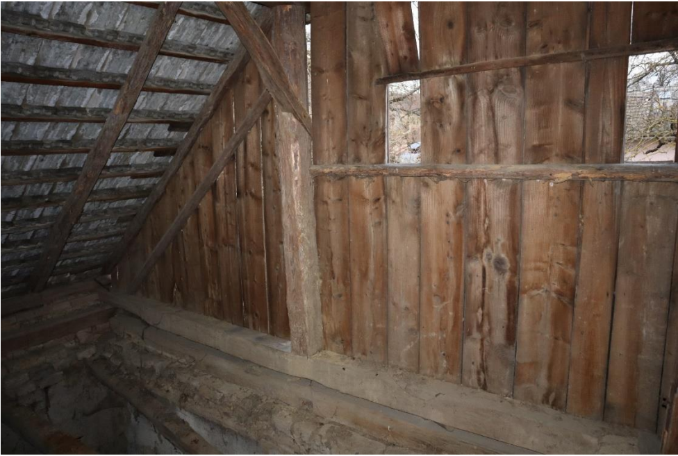
Detail štítu strechy zo strany krovu.
