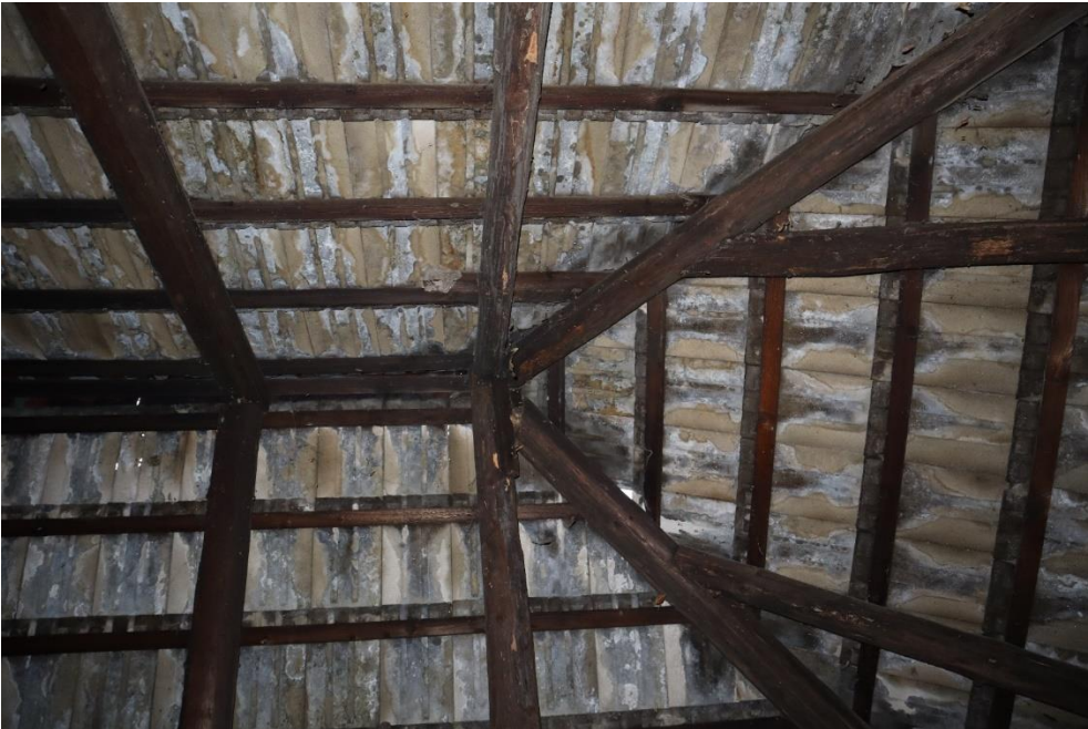
Detail spojenia krokiev v hrebeni krovu.
