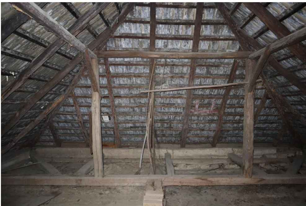
Uloženie stĺpov s prierezom 150 x 150 mm na väznom tráme.
