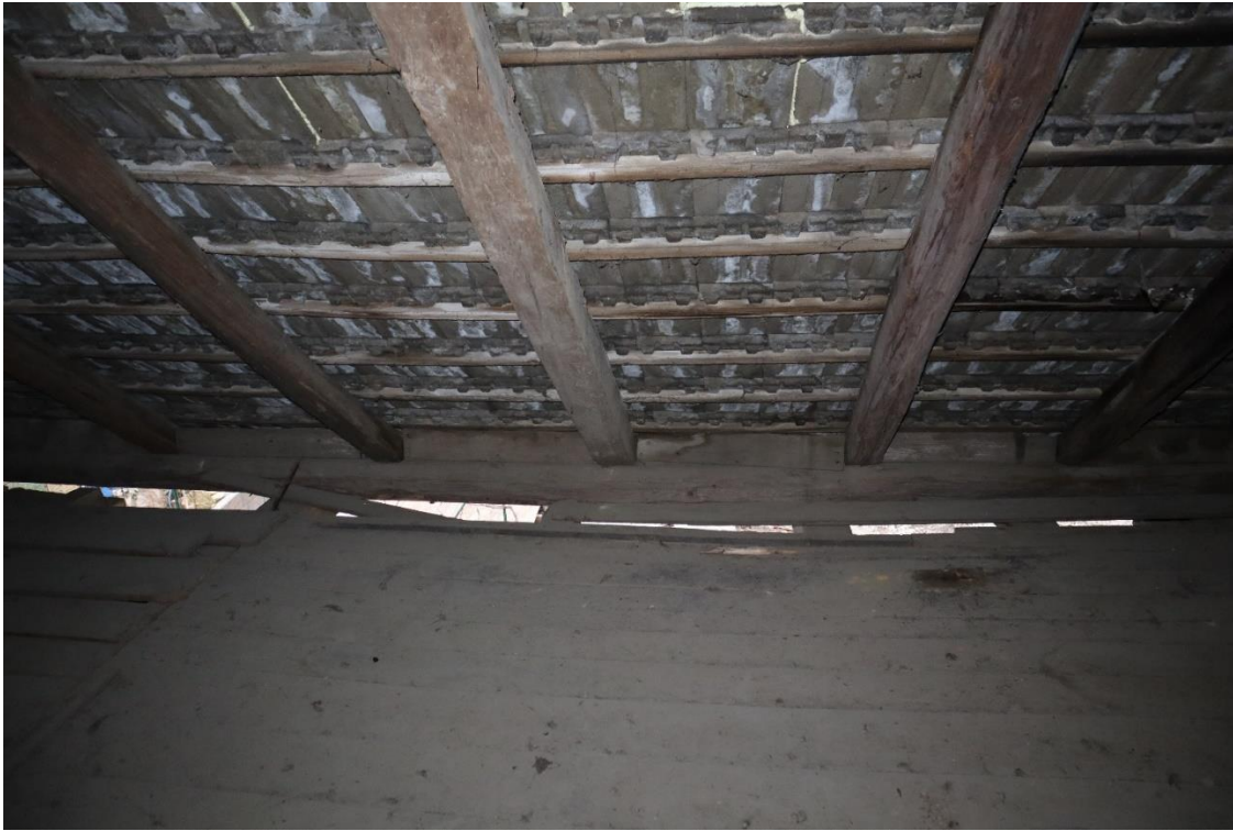
Detail nadväznosti krokiev na pomúrnicu.
