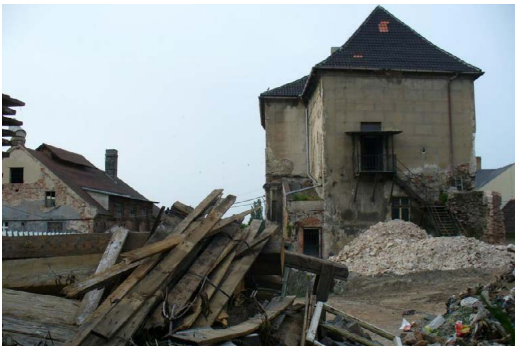
staveniště při bourání původní budovy v roce 2006
