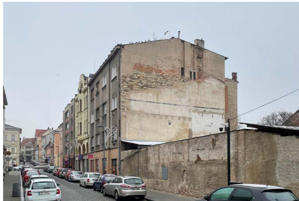
průhled do ulice Kovářská
