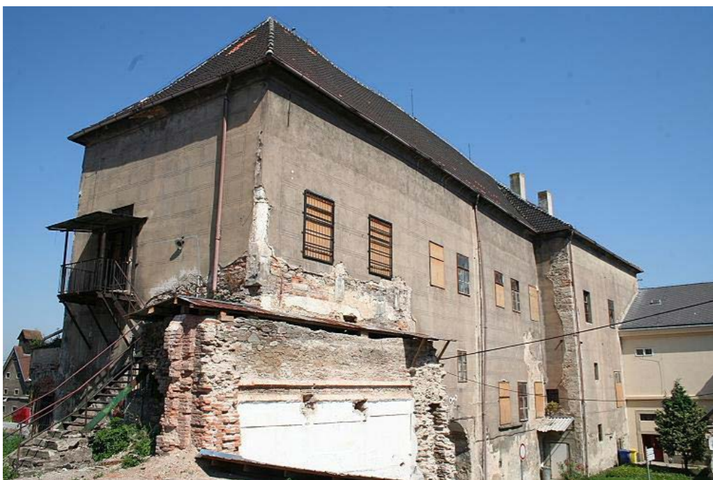
návaznost bývalé budovy provozu pivovaru na zámek
