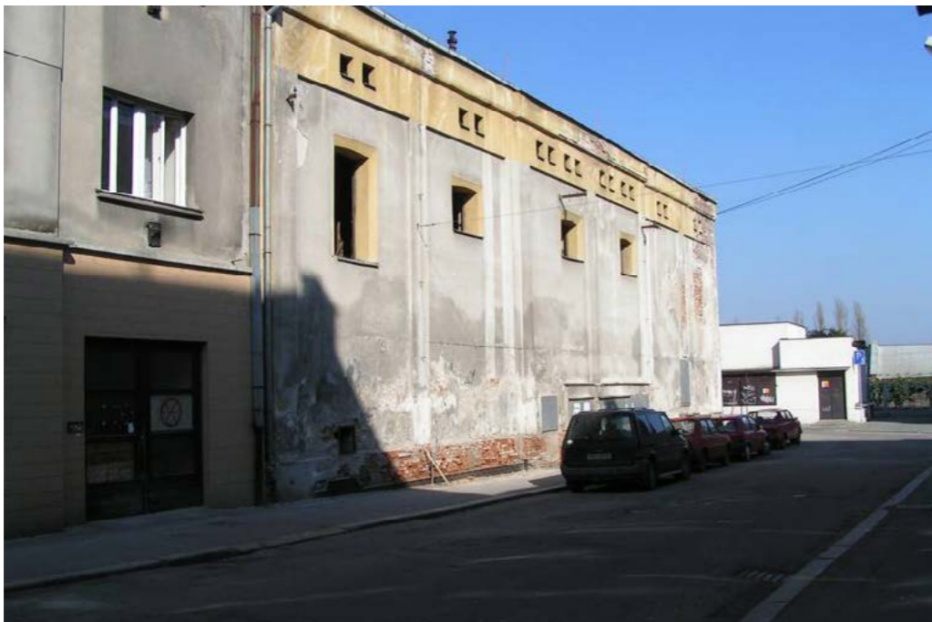
pohled na sever ulicí Kovářská
