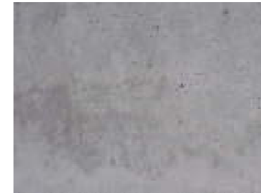
pohledový beton na stropě
