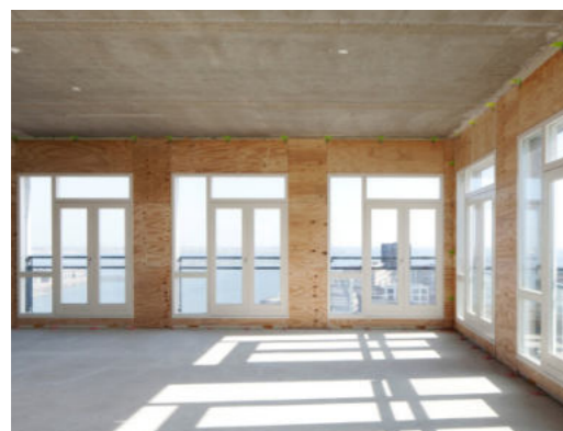
Solids Ijburg, variabilní prostory v interiéru
