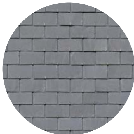
STŘEŠNÍ KRYTINA břidlice
