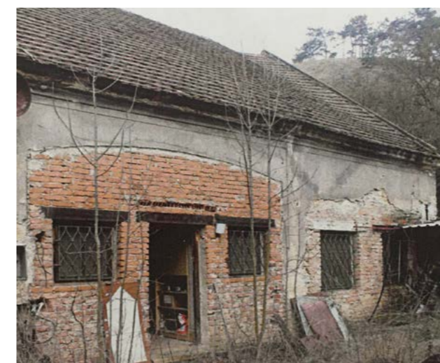
Časť južného priečelia, pohľad z dvora [SHIP]
