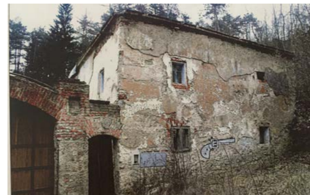
Západná fasáda, zvyšky sgrafita s kordónovou rímsou a okennou šambranou [SHPI]
