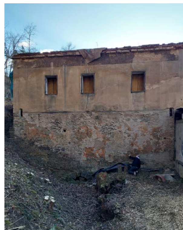
Východná fasáda, zvyšky zaklenbia bývalej stoky náhonu
