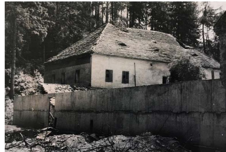
Dobová fotografia betonového muru vo východnej časti areálu [50]
