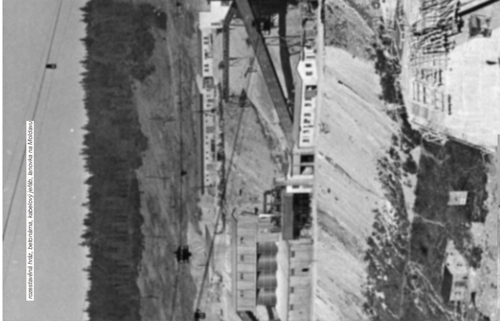
zakládání pilířových bloků přeřady
