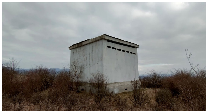
Kryt nad hlavní větrací šachtou, Richard I
