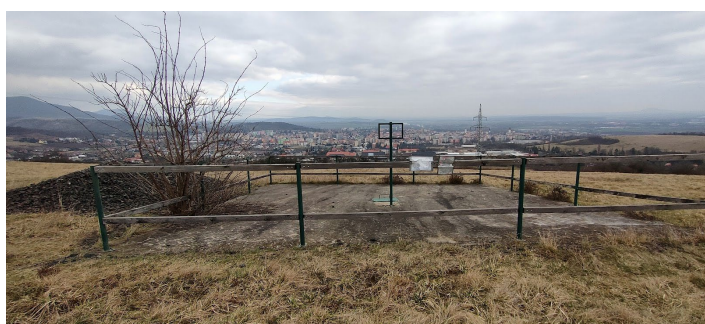
Betonová deska krycí propad nad větrací šachtou, Richard II
