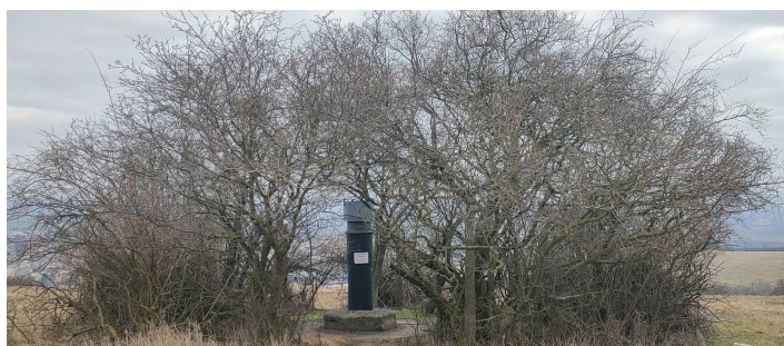
Nově vybudovaná větrací šachta jaderného úložiště, Richard II
