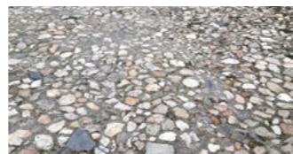
dlažba z nepravidelného kamene vysypaná štěrčkem
