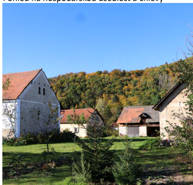
Pohled na hospodářskou usedlost a chlévy 38
