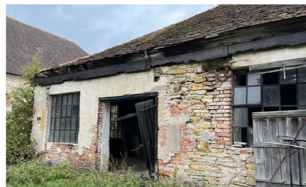
část bývalé kovářny, zadržky, změny otvorů kolna s kovárnou jižní fasáda
