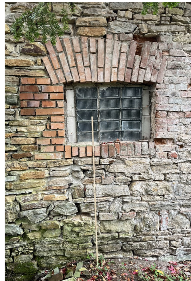
úprava okenního otvoru kravín východní fasáda
