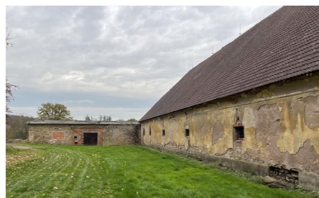
severní část, kus ohradní zdi a stodola v pozadí ovčín západní fasáda
