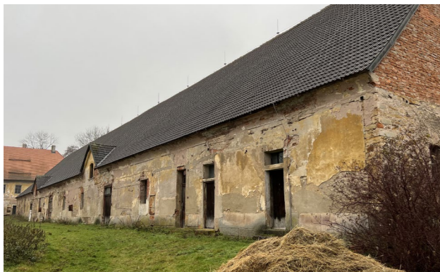
severovýchodní nároží ovčín východní fasáda - dvorní
