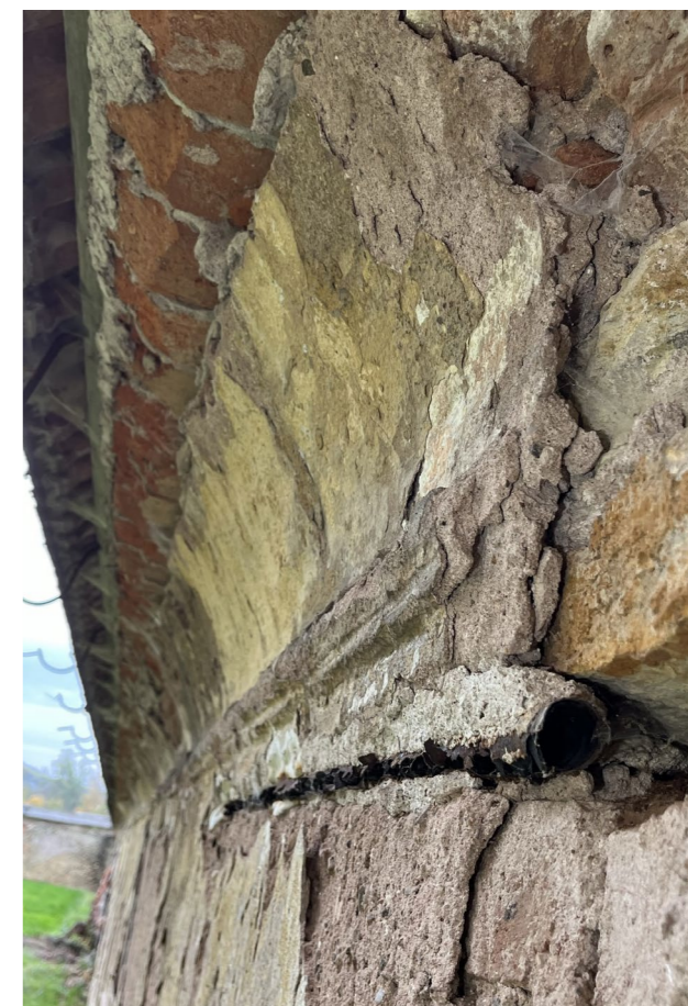
detail profilace fabionové římsy ovčín východní fasáda
