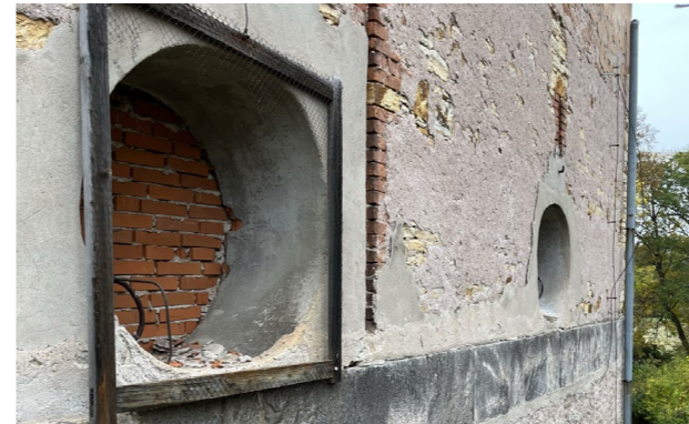
kruhové otvory po větrácích úprava z 2. poloviny 20. století stodola jižní fasáda
