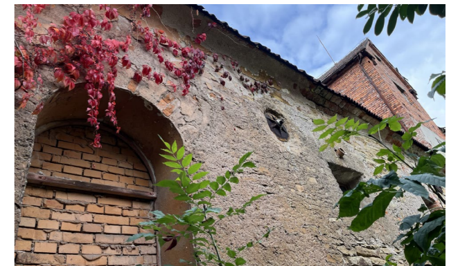
zazdívký okenních otvorů kravín východní fasáda
