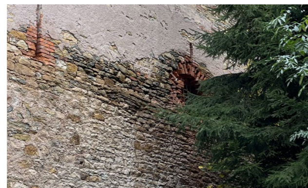
kruhový otvor po větráku v místě škvíry úprava z 2. poloviny 20. století stodola severní fasáda
