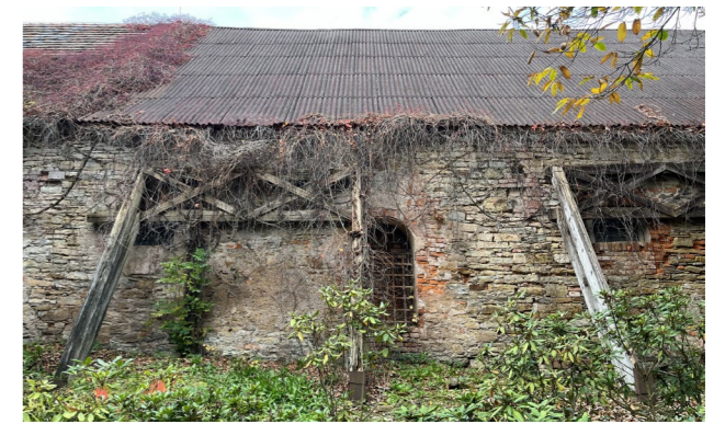
dřevěné podpory proti vyvalení zdiva kravín východní fasáda
