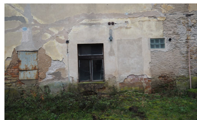
detail fasády s četnými opravami ratejna západní fasáda
