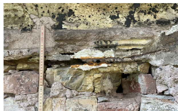
detail profilace fabionové římsy ovčín východní fasáda
