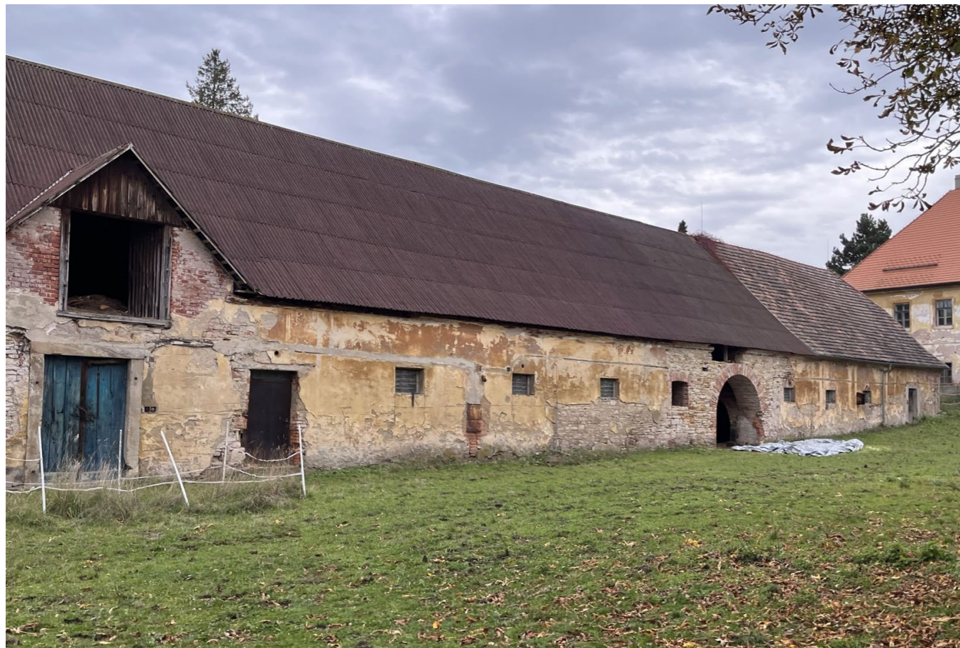
severní část se střešní krytinou z vlnitého plechu, sedlový vikýř (ve střeše původně volské oka) zdivo průjezdu vyvaleno kolapsem klenby, průjezd rekonstruován kravín západní fasáda - dvorní
