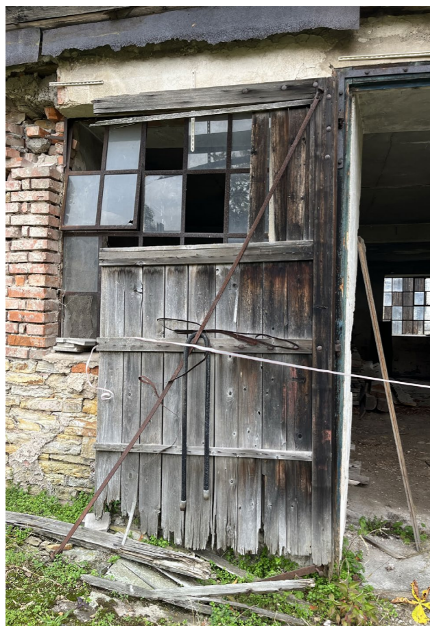
detail destruovaného křídla vrat kolna s kovárnou jižní fasáda
