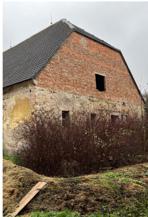
ovčín severní fasáda
