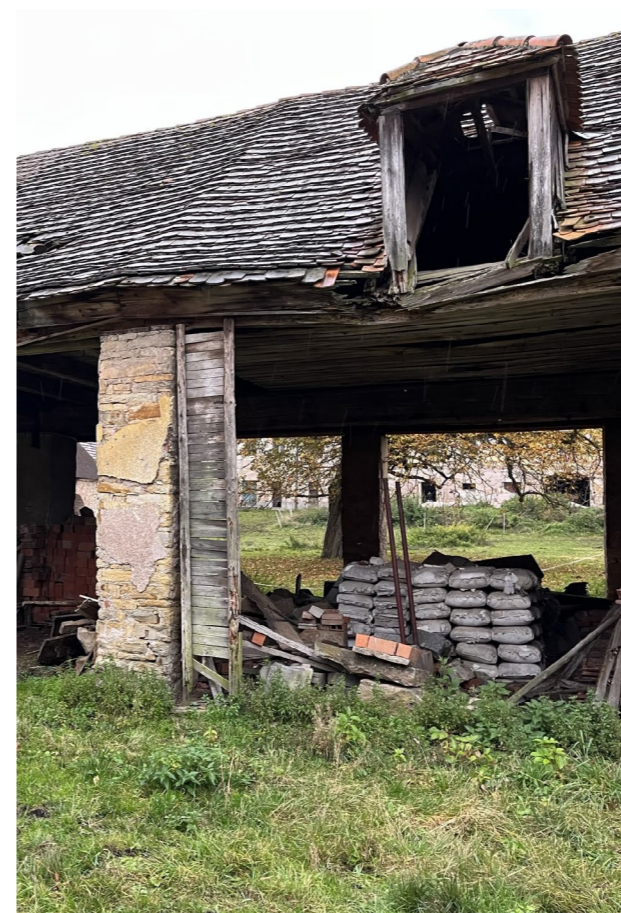
střešní vikýř kolny v havarijním stavu kolna s kovárnou jižní fasáda
