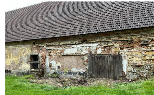
negativ po konstrukci posuvných vrat místo bývalého přístavku z 2. pol. 20. stol. ovčín východní fasáda
