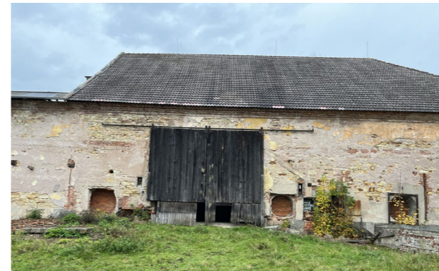
vrata východního neprůjezdného mlatu kruhové otvory po větrácích stodola jižní fasáda - dvorní
