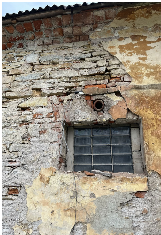
detail upravovaného okenního otvoru zbytky omítek bez profilace kravín západní fasáda - dvorní
