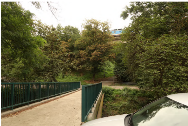
most přes Rokytku pod viaduktem [7] (Michal Kuzemský 2023)
