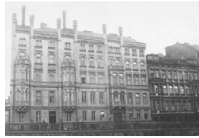
[1] Novogotická budova Eliščiných lázní
