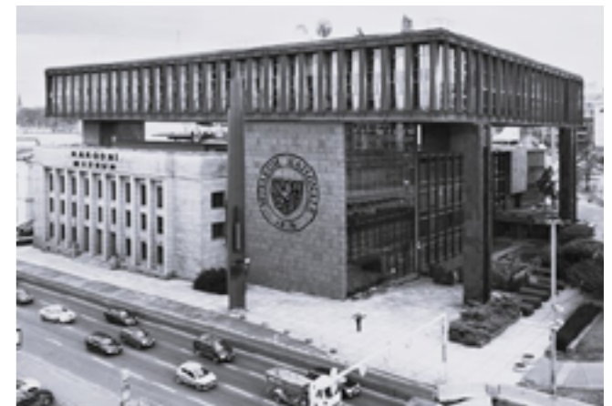
[4] Budova Federálního shromáždění, Praha
