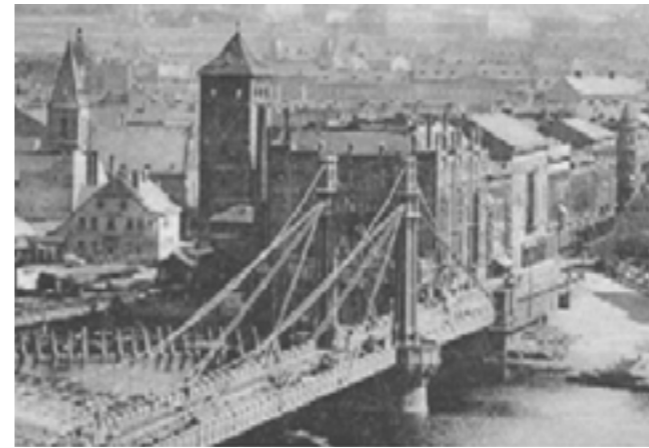
[4] Výstavba mostu F. Josefa
