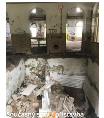
Současný stav / vstup kaple
