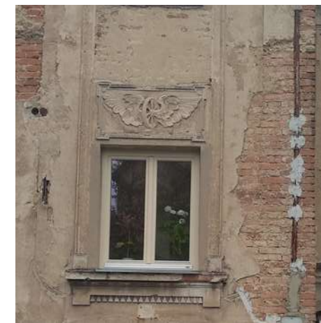
26b. bývalá drážní budova Smečno
