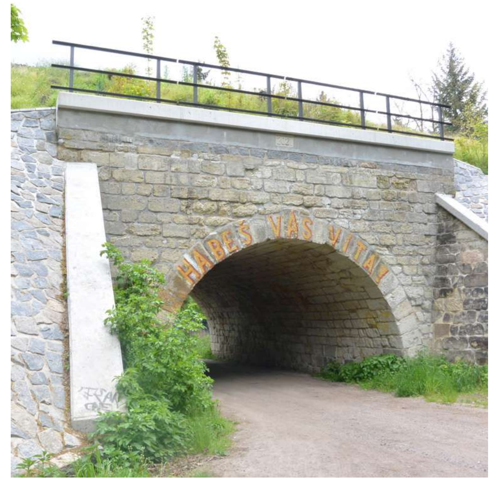
60a. podchod pod železnici - původní napojení úzkokolejky
