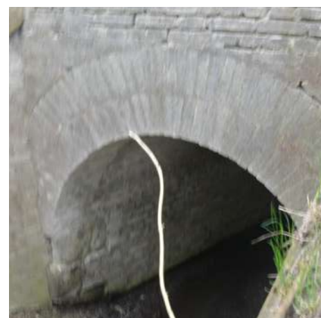
33. původní most přes potok
