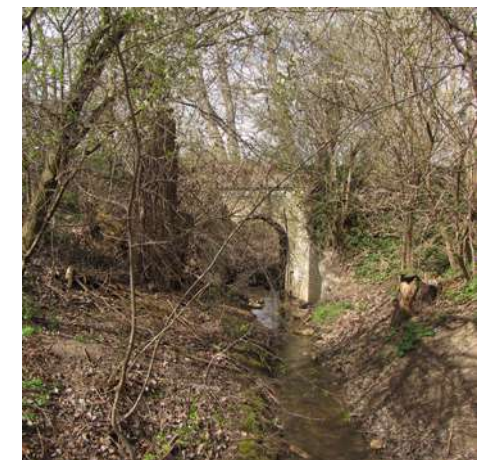
50. most přes potok - Studeněves
