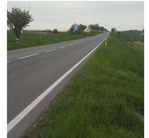
16. silnice Smečenská u Pyrámu
