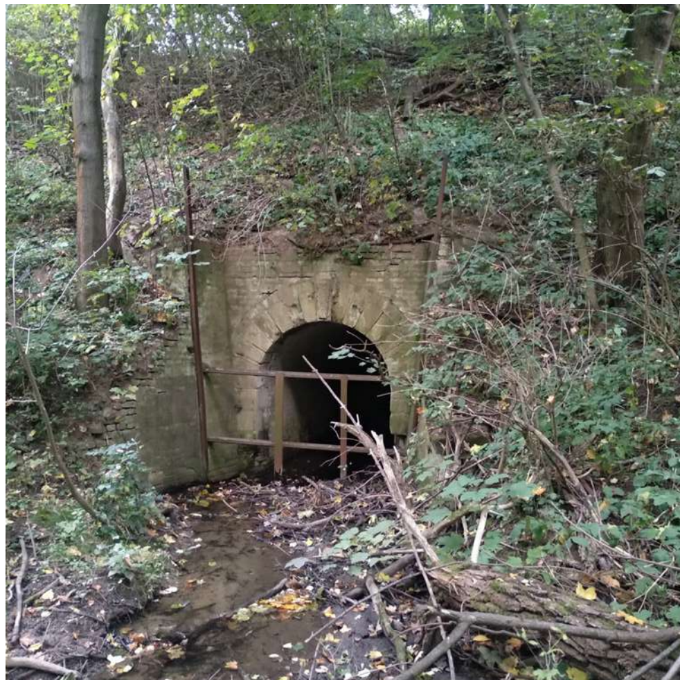
40d. most Šternberk - propust pro potok
