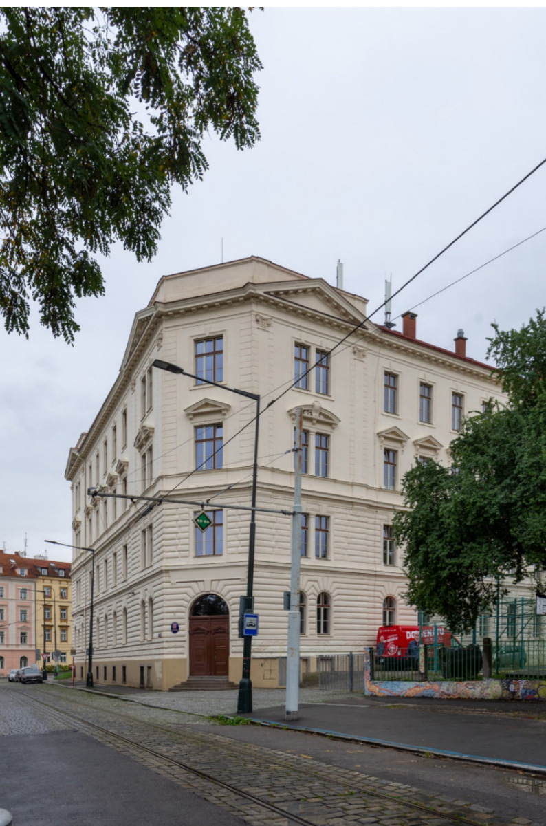
zadní vchod pro studenty, foto Daniel Dworschak západní fasáda budovy slepý štít budovy, foto Daniel Dworschak
