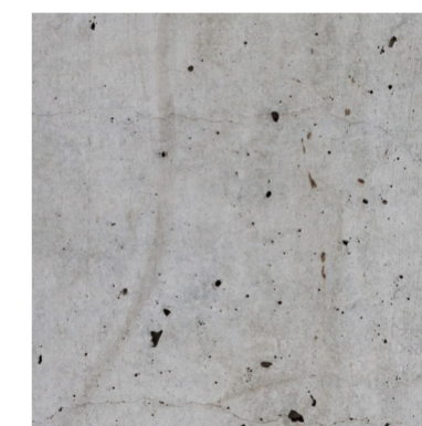
Obvodové stěny - Pohledový beton - PU nátěr
