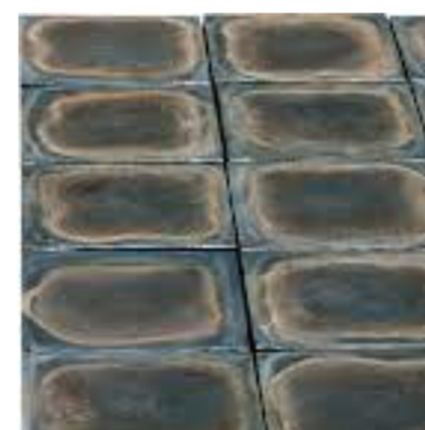
Podlaha restaurace -Dlažba z taveného čediče
