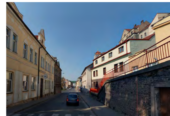
Obrázek 81 Křížkové schody stíci do Nádražní ulice
