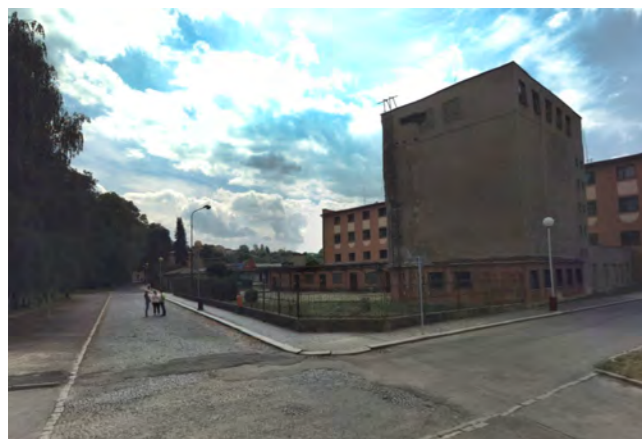
Obrázek 82 Objekt pekárny Suchar od Podoleckého dvora
