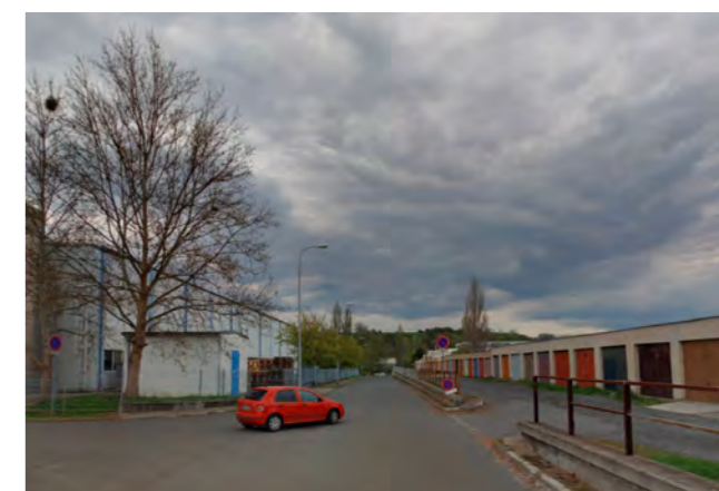
Obrázek 77 Jednopodlažní garáže v ulici Pod Borkem
