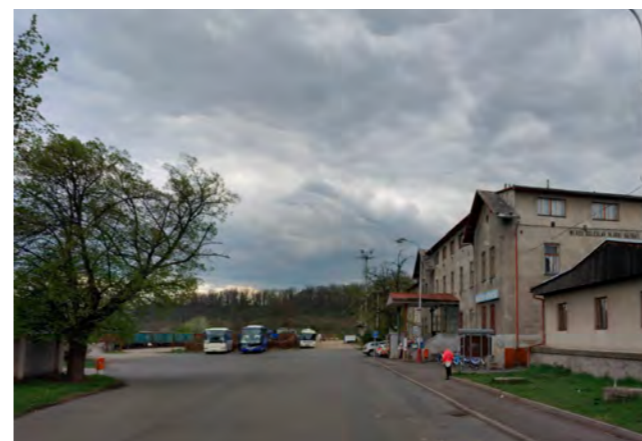
Obrázek 72 Hlavní železniční nádraží v Čejetických
