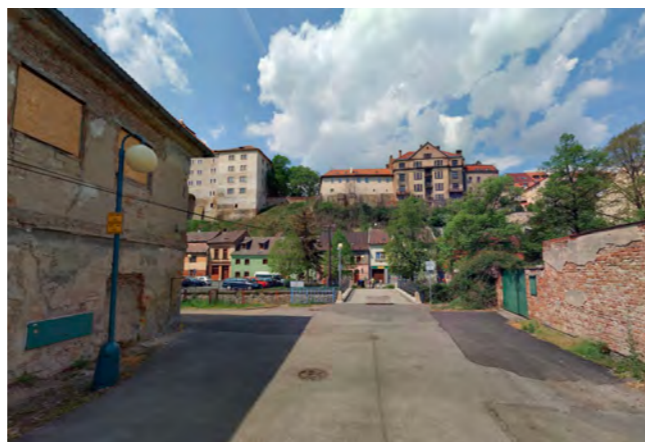
Obrázek 67 Lávka přes Klenici u Podoleckého dvora
