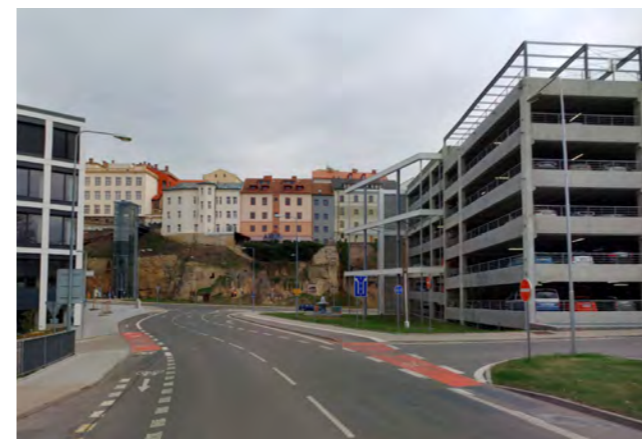
Obrázek 84 Šestipodlažní parkovací dům mezi komerčními objekty na Ptáček ulici
