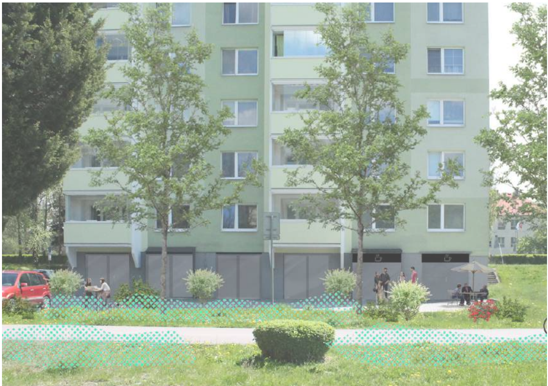
D - orientácia V-Z, transformované garáže na byty a prenajímateľný priestor
