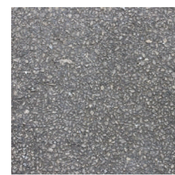
Před vstupními dveřmi_ Pro manipulační plochu kamionu je vodopropustný beton.
