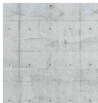
Nosné stěny objektu_ Pohledový beton s otisky bednicích desek.
