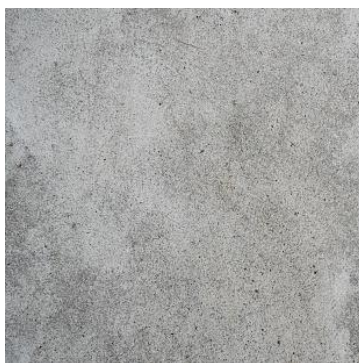
Nosná konstrukce – Beton
