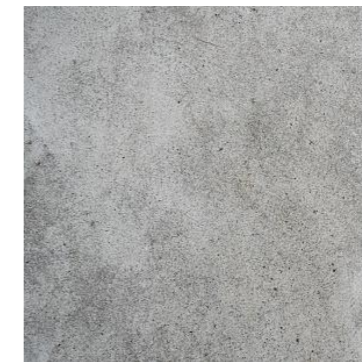
Nosná konstrukce – Beton
