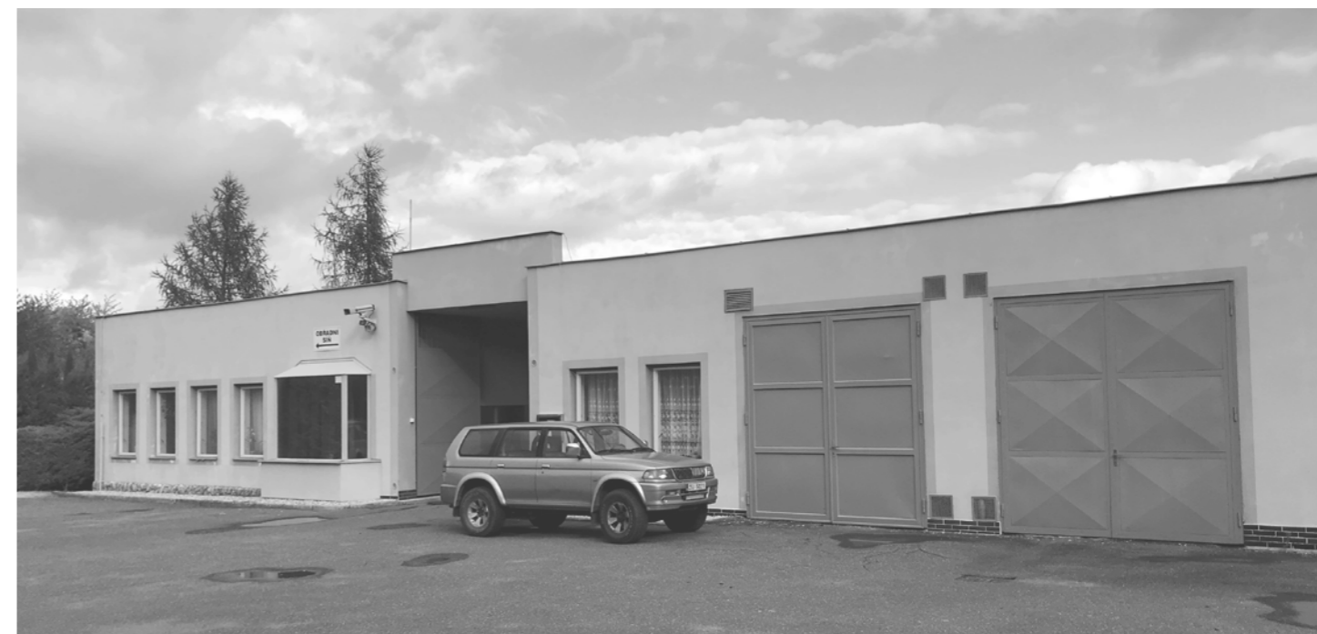
Pohled na vstup a vjezd do Krematoria
