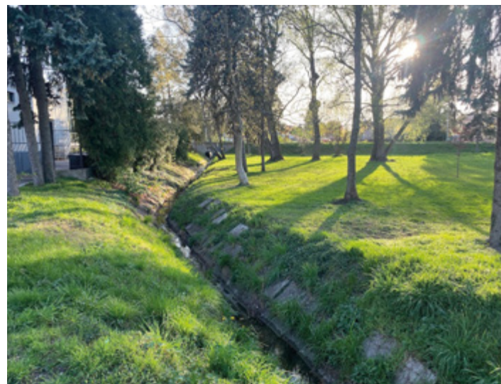
Opevněné koryto Hovorčovického potoka ostře lichoběžníkového tvaru protékající parkově upravenou plochou v Hovorčovicích.
