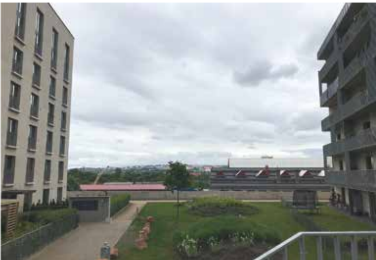
27. Pohled na depo přes bytový komplex Krejcárek
