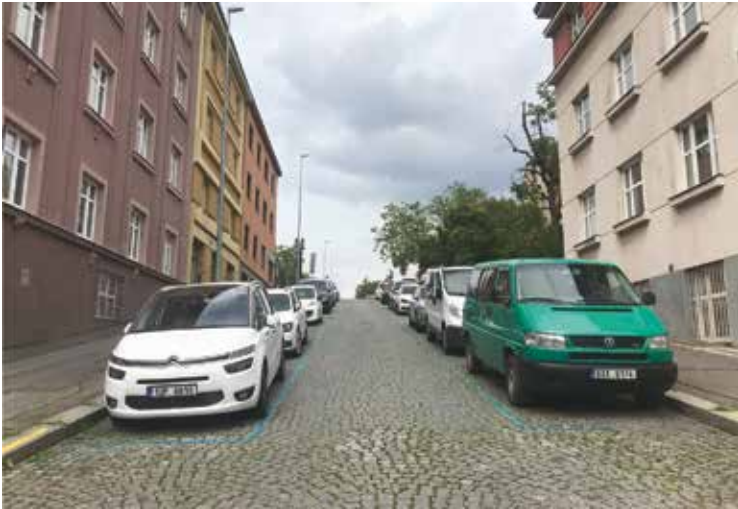
16. Ulice Hraniční - zvedání terénu
