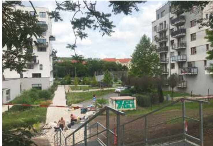
48. Průchod do Rokytky přes bytovky
