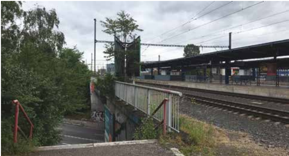
4. Schody z nástupiště do ulice K Žižkovu
