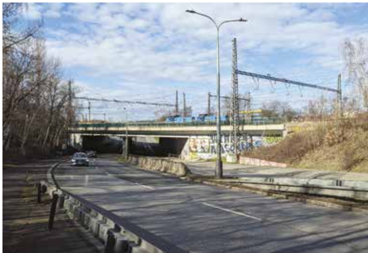
31. Podchod pod železniční tratí podél Spojovací
