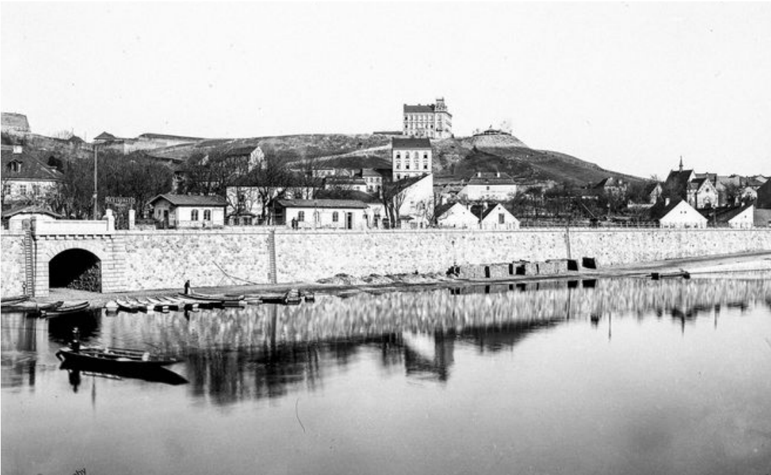
Pohled na Podolí z podolské hráze, v pozadí na kopci „Slepičárna“. V vlevo v popředí viditelný zahradní hostinec „Na Dolejší“, který je v provozu dodnes. Vpravo viditelná vesnická zástavba před vybudováním družstevních bytů v 60. letech.
