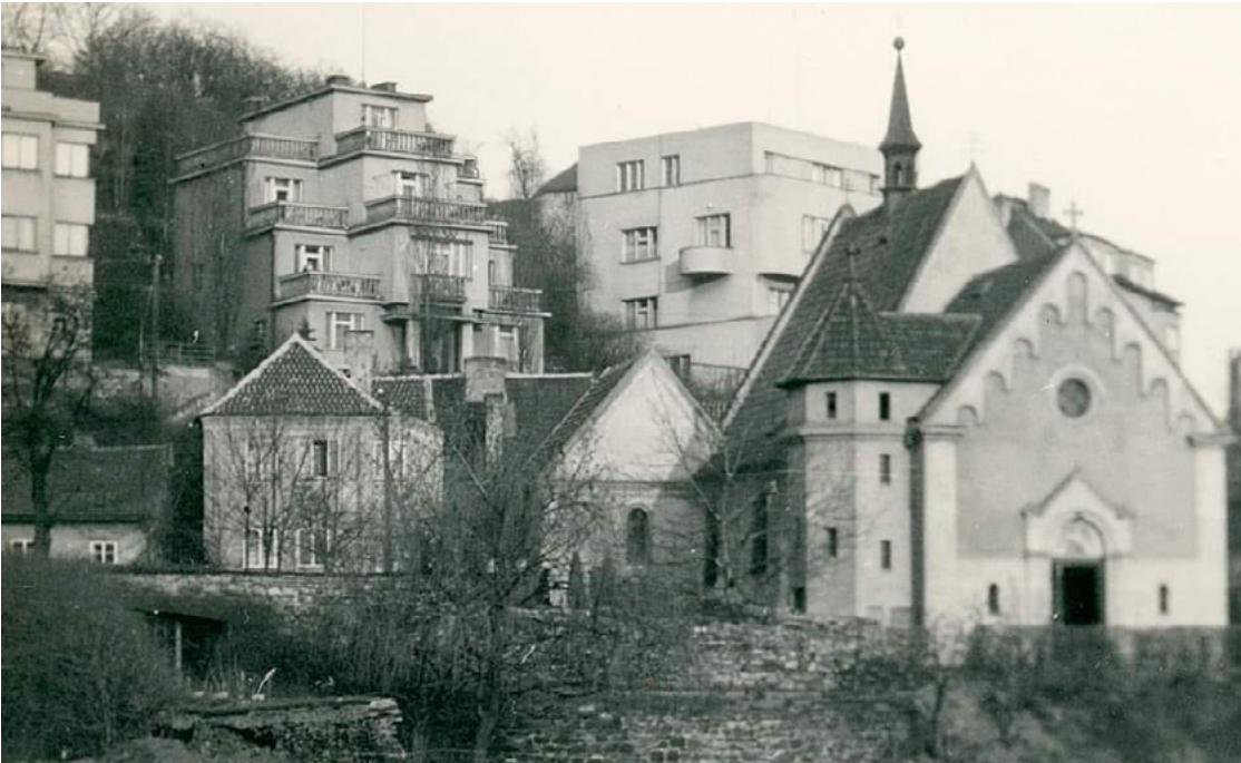
Kostel sv. Michala s okolní původní zástavbou, dnes již neexistující. V pozadí prvorepublikové vily ve svahu. Všechny tři zachycené vily stojí na místě dodnes. Fotografie je cenným dokladem zmizelé atmosféry starého Podolí
