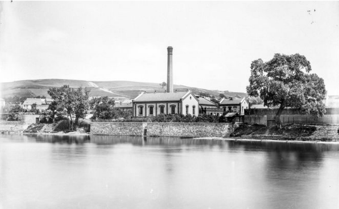
Pohled na budovu Vinohradské vodárny v Podolí (zbořena 1922) – západní strana. Fotografie vyobrazuje neexistenci spojitého nábřeží přístupného pro kolemjdoucí.
