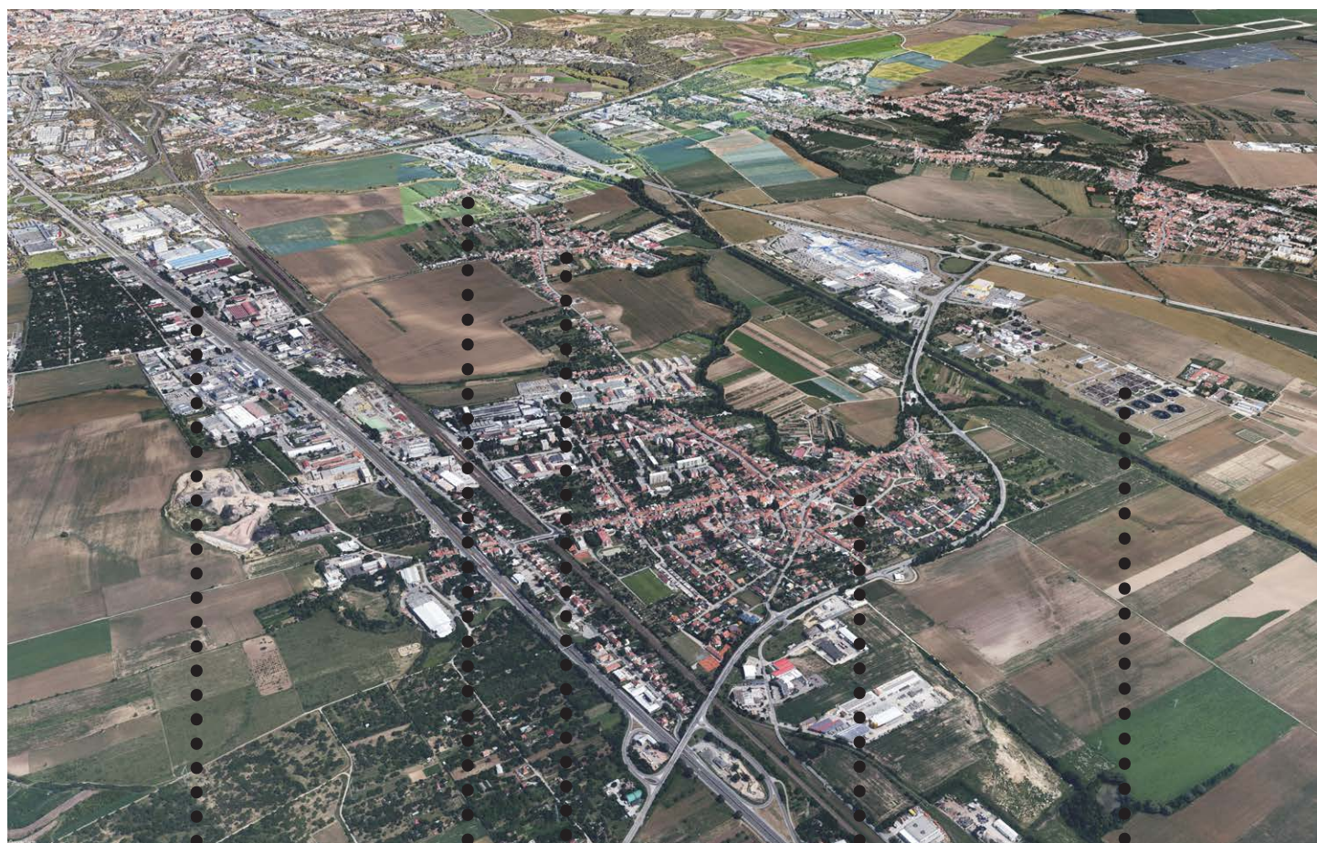
Dálnice D52 D. Heršpice Přízřenice Modřice ČOV
