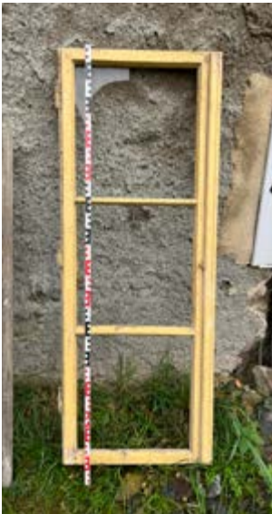
Fotodokumentace Pohled z exteriéru
