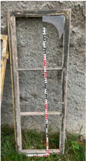
Pohled z interiéru
