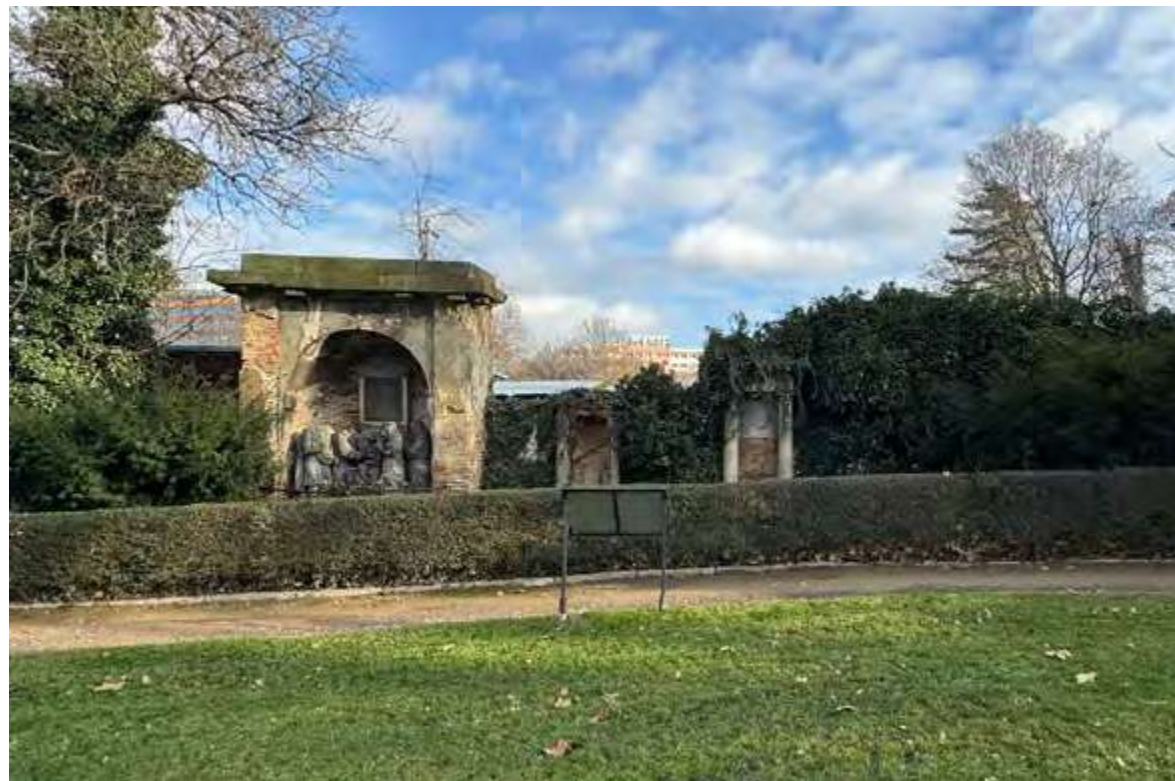
25 hřbitovní zeď oddělující pozemek od Kaple sv. Rocha
