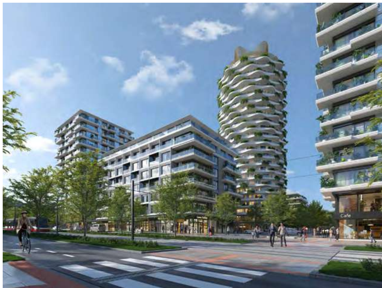
20 Central group, Eva Jiříčná - na místě původní Ústřední telekomunikační budovy
