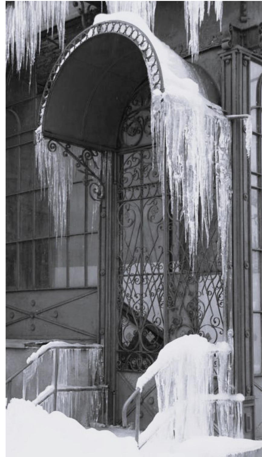
vstup do prosklené části továrny [obr.24]
