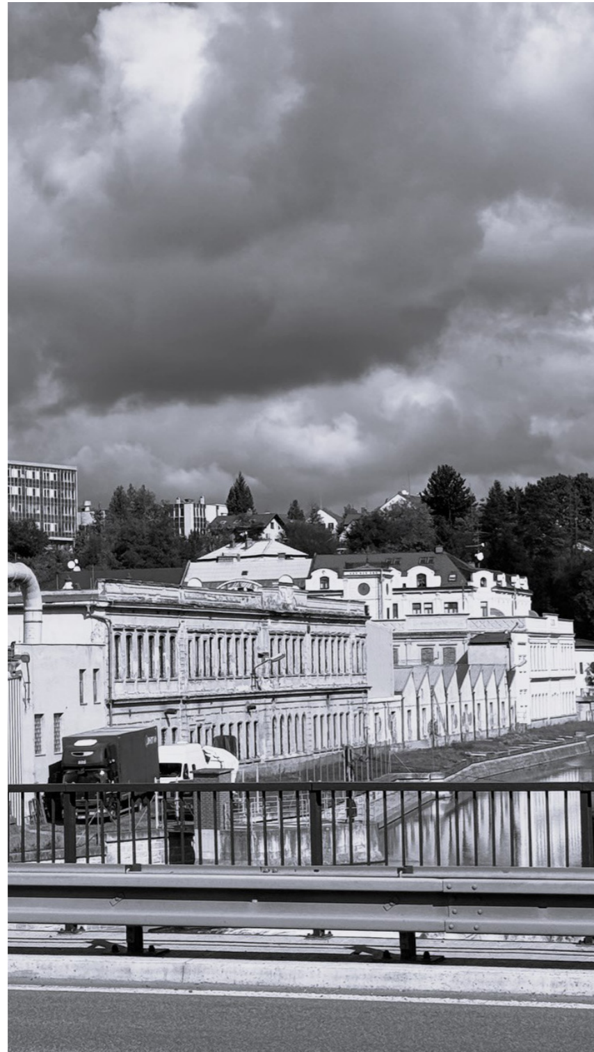
pohled ze silničního mostu
