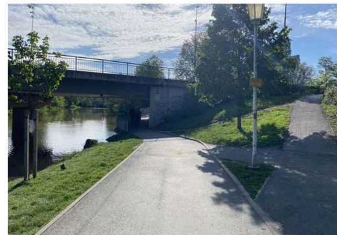
5 Napojení na most a úzký průchod pod mostem
