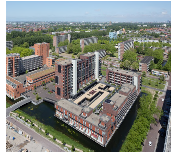
[obr. 26] dostavění do souborů panelových domů
