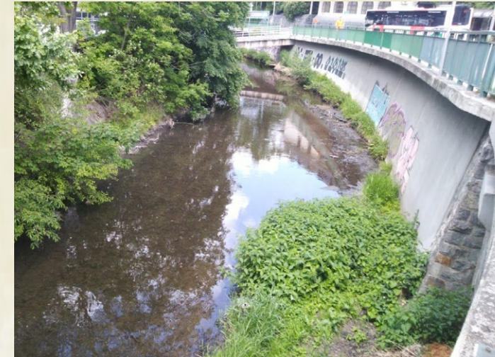
Obr. 34: Zpevněné koryto toku Botiče
