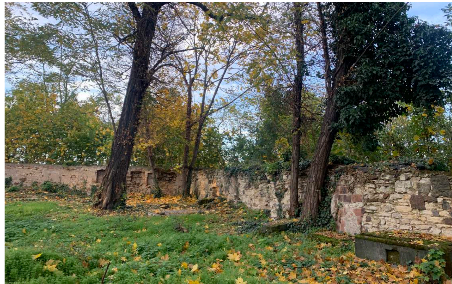
Fotografie historické opukové zdi s náhrobky
