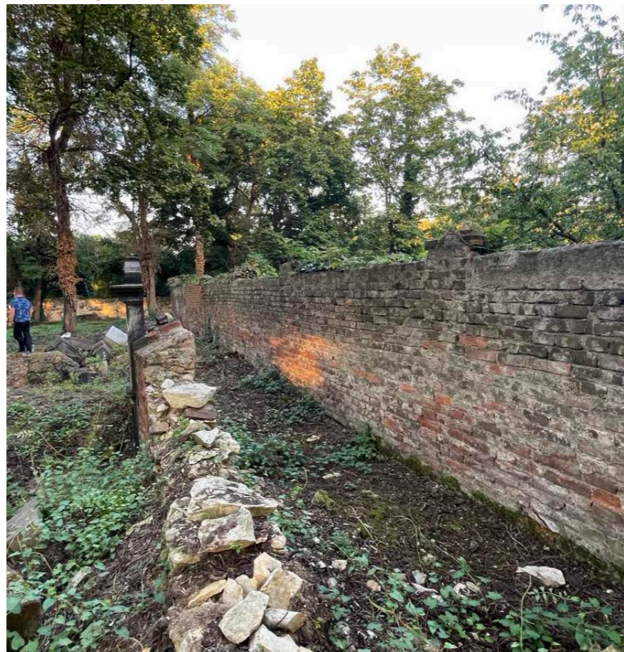
Fotografie původní zdi
