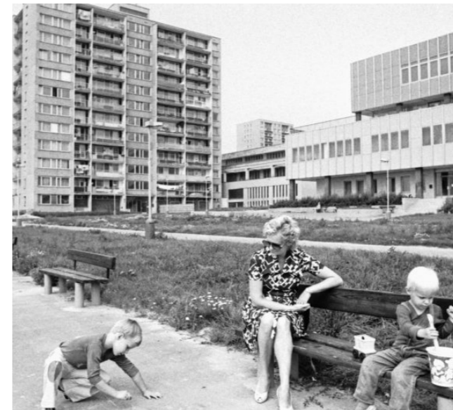
System „VVÚ-ETA” within housing estate Jižní Město, Prague xix
