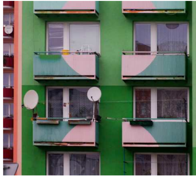
Coloured façades and balconies, Máj in České Budějovice xiii
