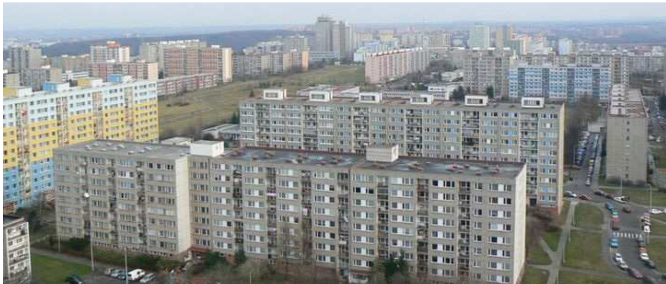
Partly renovated façades of the system „VVÚ-ETA”, Jižní Město Prague xxiii
