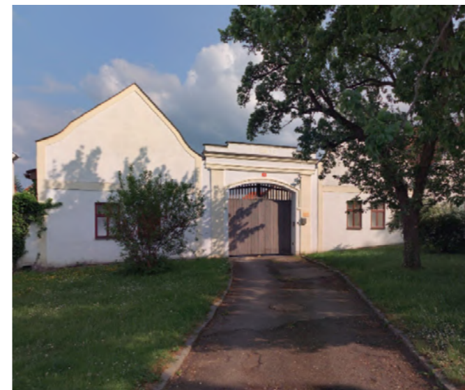
Dům na návsi obce Jenštejn (zdroj: vlastní)
