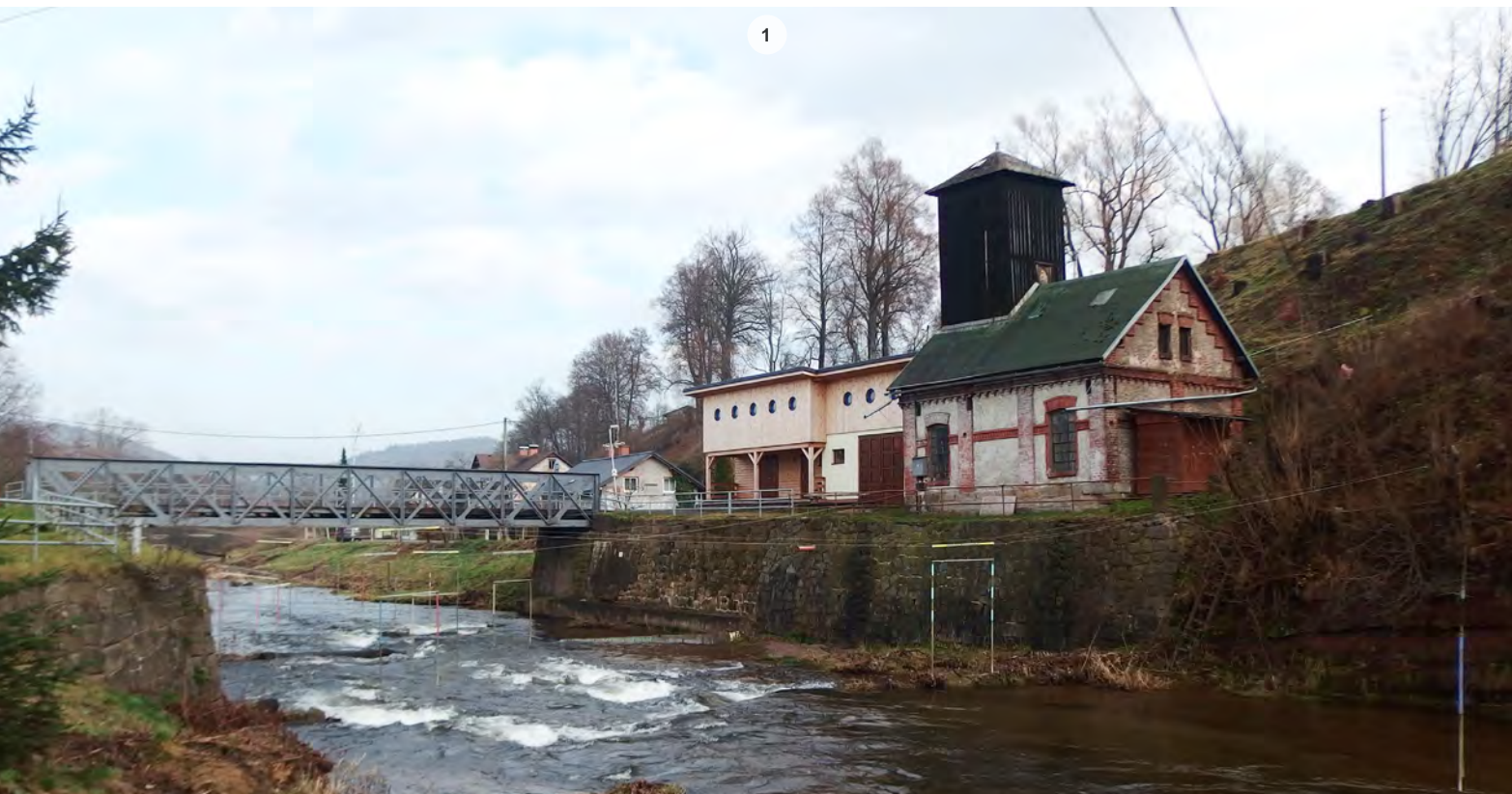
1 Řeka Úpa s mostem, novou loděnicí
