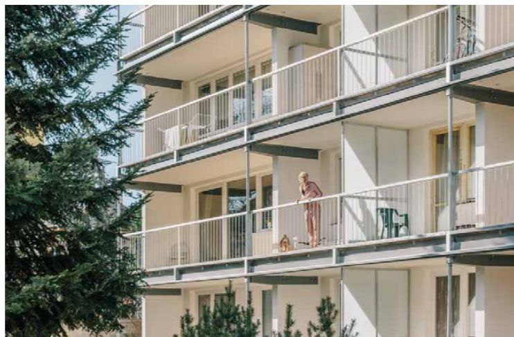
Rozšíření lodžii panelového domu_RE:architekti_2022
