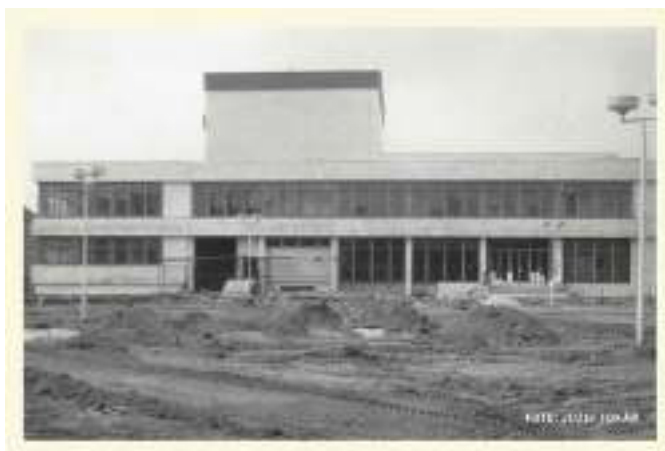
Fig.157 Pohľad na fasádu
