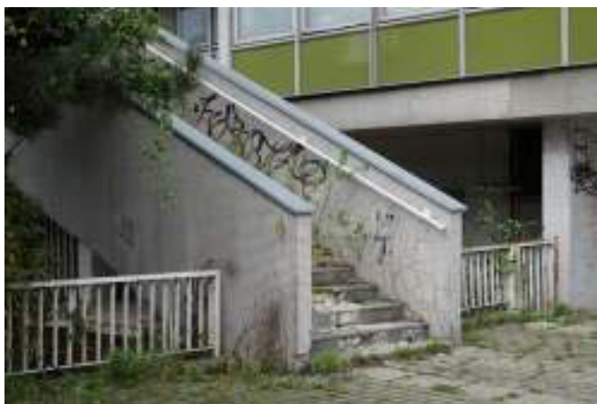
Fig.70 Vstup na rampu z ulice
