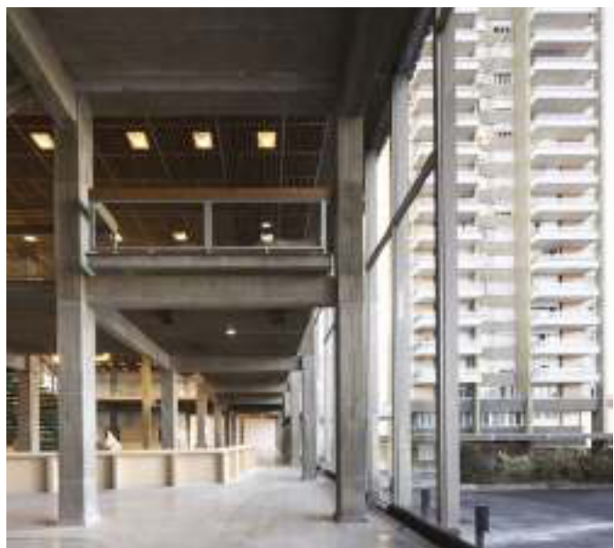
Fig.167 Interiér po rekonštrukcii
