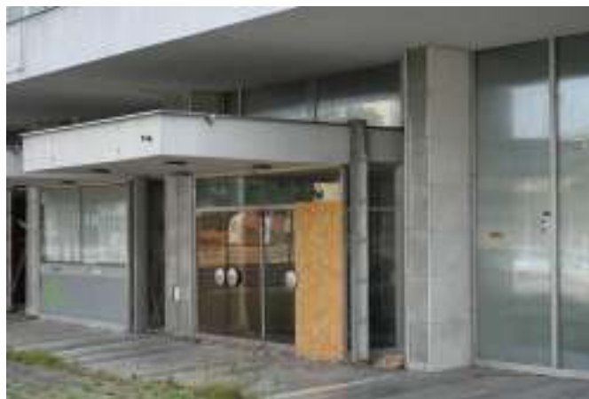
Fig.71 Hlavný vstup s pokladňou
