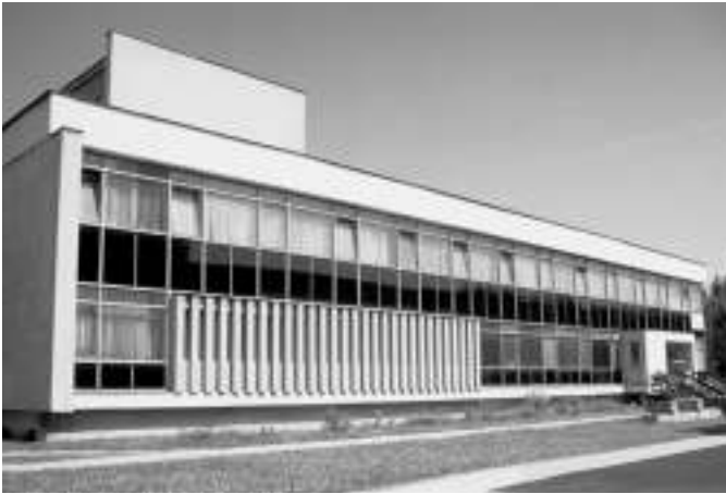
Fig.153 Pohľad na fasádu
