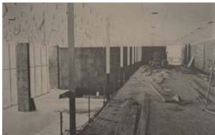
Fig.22 Pohľad na balkón estrády, výstavba
