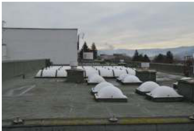
Fig.81 Svetlíky nad baletnou sálou
