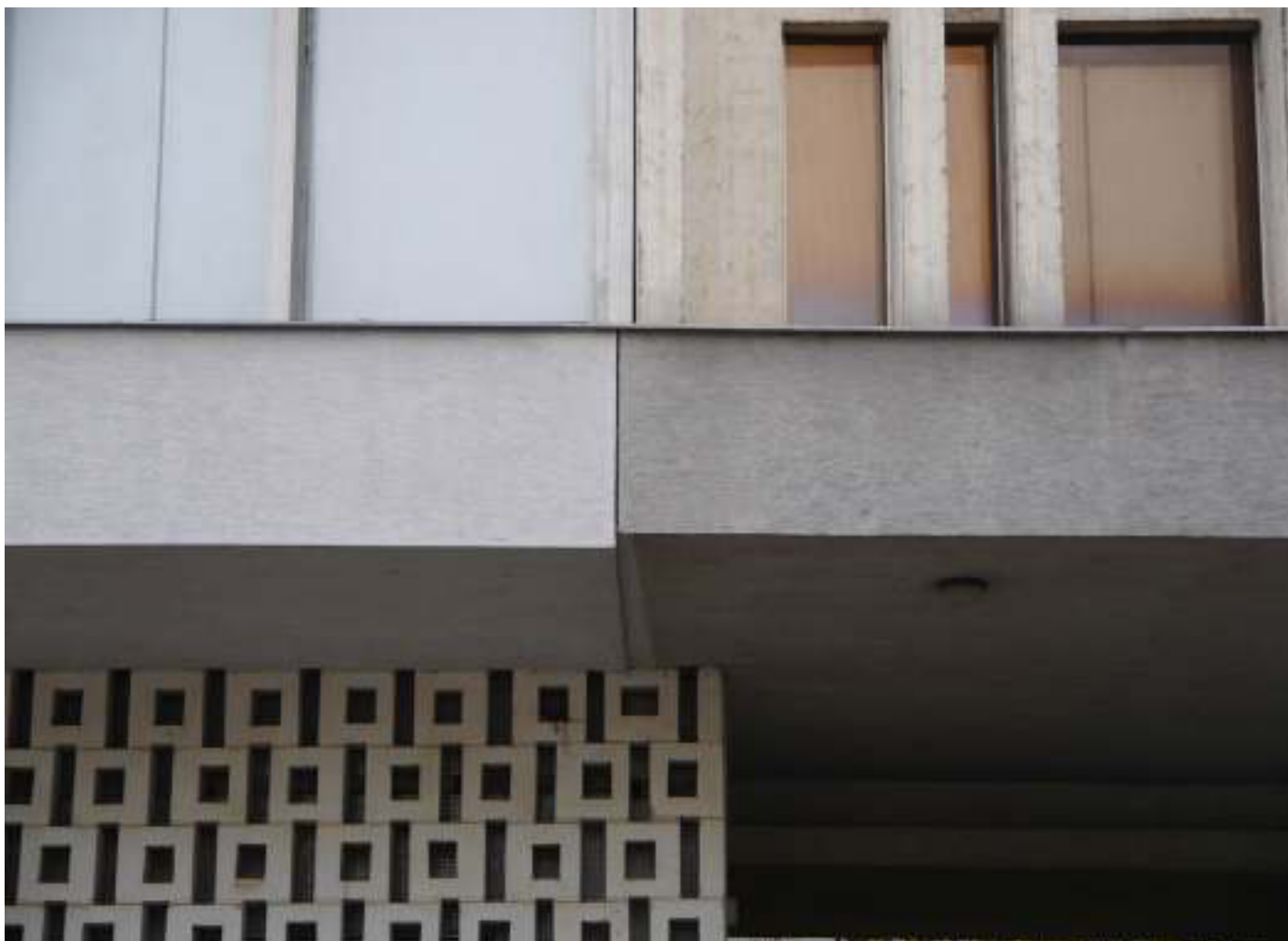
Fig.129 Dilatační spára, rozličné materiály použité na fasáde; Zdroj: autor. fotografia
