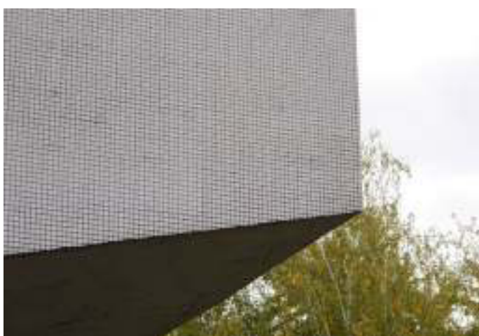
Fig.130 Pohľad na obklady fasády
