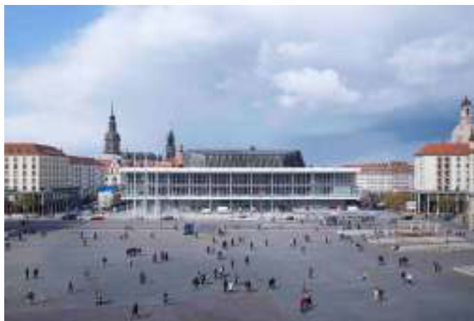
Fig.159 Pohľad na fasádu a hlavný vstup
