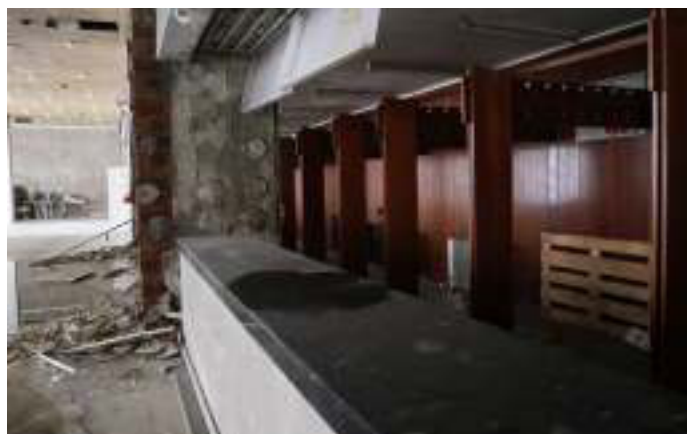
Fig.134 Obrázok , drevený obklad stien šatní, mramorová doska šatne, odpadnutý mramorový obklad zo stĺpov; Zdroj: autor. fotografia
