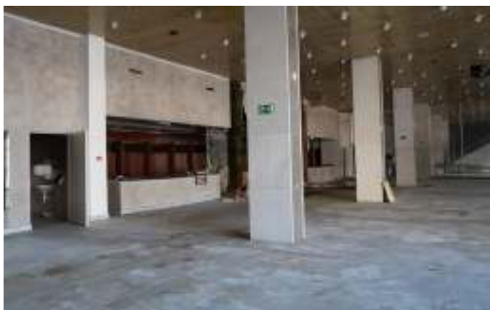
Fig.133 Obrázok , mramorový obklad a podlaha, kovový perforovaný podhľad so svetlami; Zdroj: autor. fotografia
