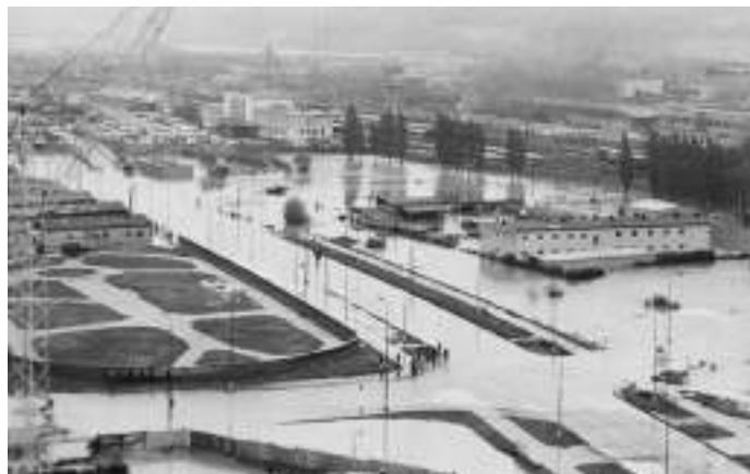
Fig.16 Roh v pravo dolu výstavba Domu Kultúry, povodeň 1974
