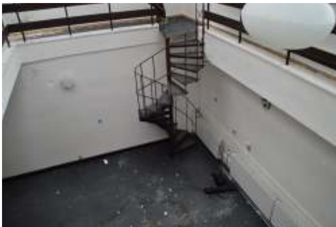
Fig.116 Bývalý dvojposchodový ateliér
