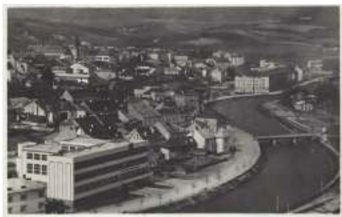
Fig.12 Pohľad na ZUŠ, budovy ktoré podľahli demolícii a pôvodné koryto Hrona
