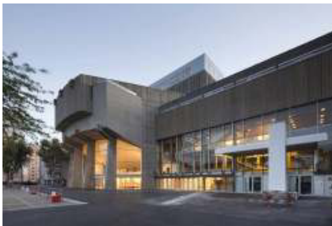
Fig.164 Pohľad na fasádu
