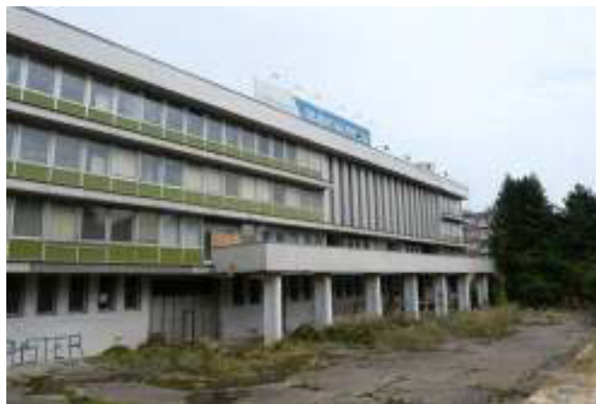
Fig.63 Pohľad na južnú fasádu, stinolamy, rampu
