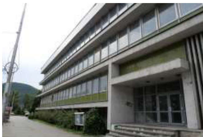
Fig.64 Vstup do reštauračnej časti, východná fasáda
