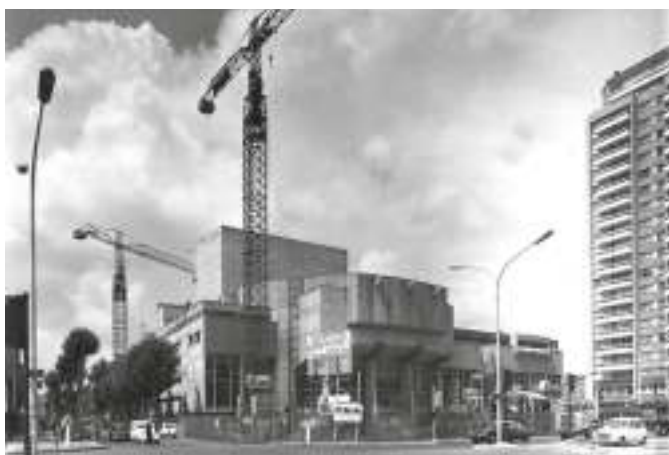
Fig.165 Archívny záber výstavby
