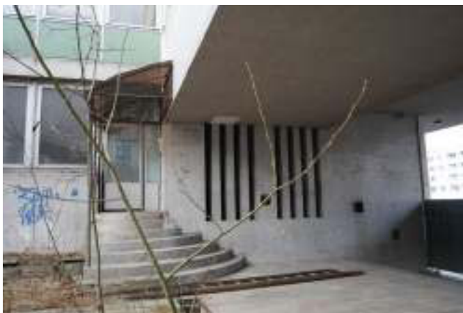
Fig.76 Druhotne doplnený vstup do západného krídla
