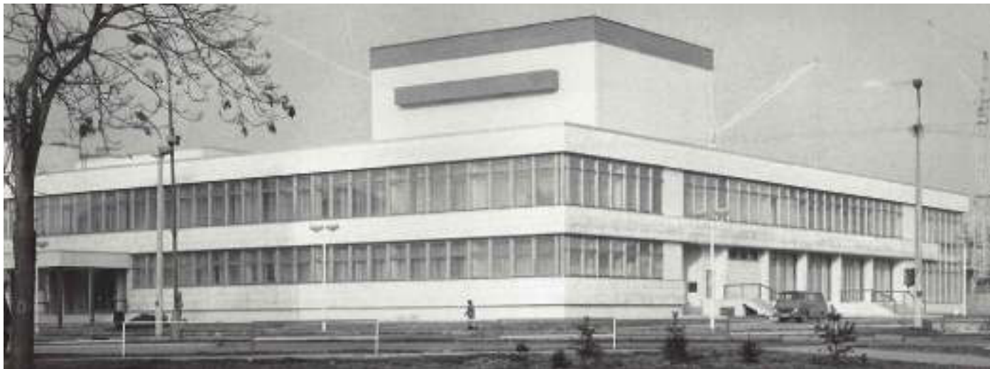
Fig.156 Pohľad na fasádu
