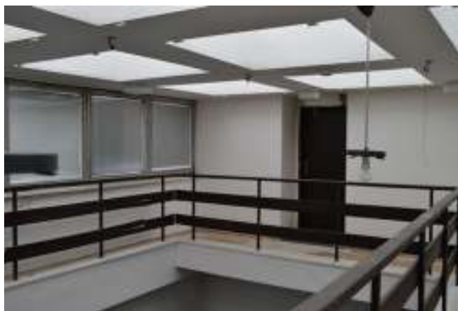
Fig.114 Bývalý dvojposchodový ateliér
