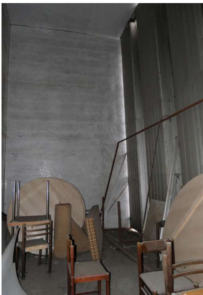
Fig.170 Lodžia, pohľad na východnú stranu
