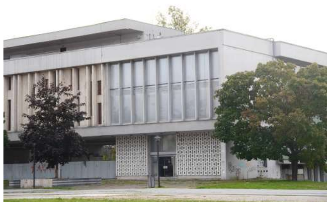
Fig.40 Vstup do severného krídla
