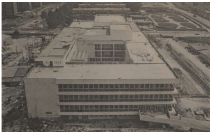
Fig.15 Západný pohľad, výstavba
