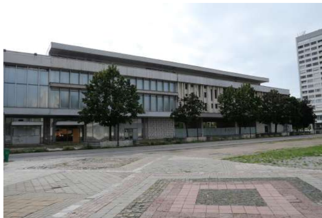
Fig.44 Pohľad na severnú fasádu z parkoviska
