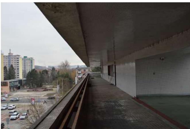
Fig.103 Balkón na streche, severná strana
