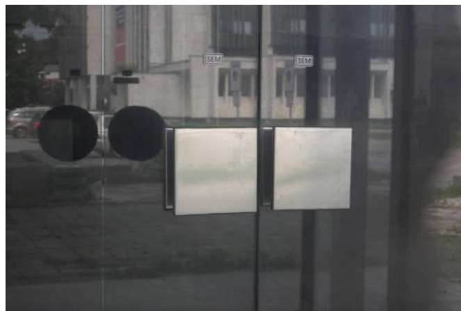
Fig.46 Pohľad kľučku hlavných dverí
