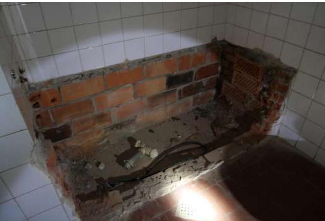
Fig.155 1-67 byt, kúpeľňa, prázdny priestor po vane
