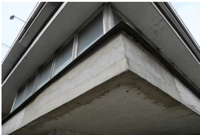
Fig.95 Opadnutý keramický obklad mozaiky
