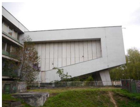
Fig.79 Pohľad na západnú fasádu kina
