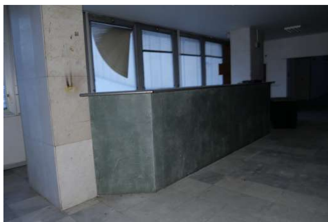
Fig.186 1-87, chodba s vstavaným barom
