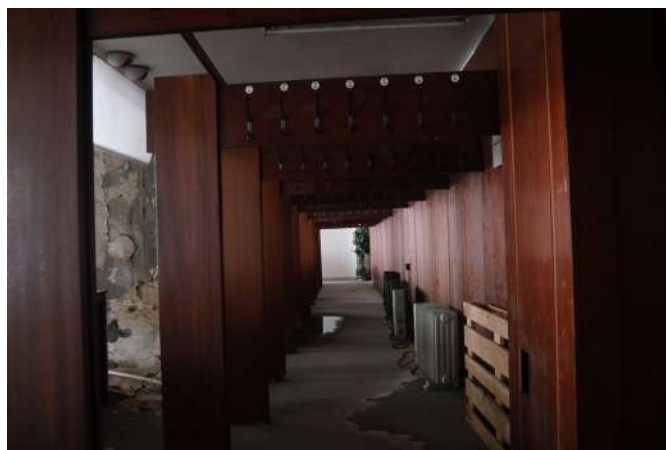
Fig.150 1-26, šatňa, háčiky na zavesenie kabátov
