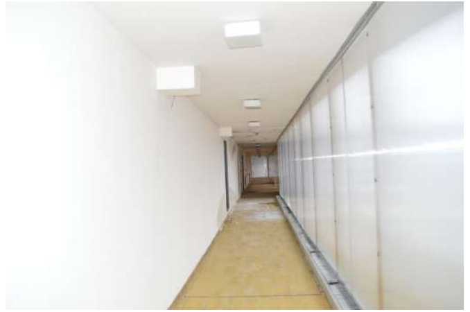
Fig.197 3-57, spojovacia chodba, zvnútra lexan pred sklom
