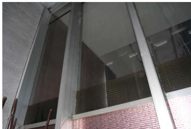
Fig.168 Presklenná stena lodžie
