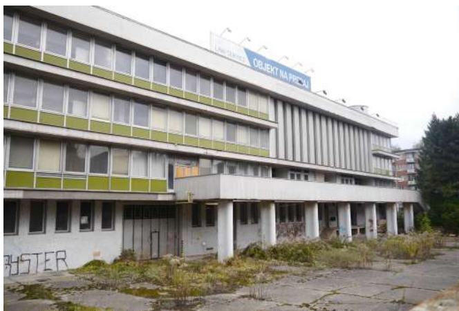
Fig.80 Južná fasáda, rampa a stĺpky
