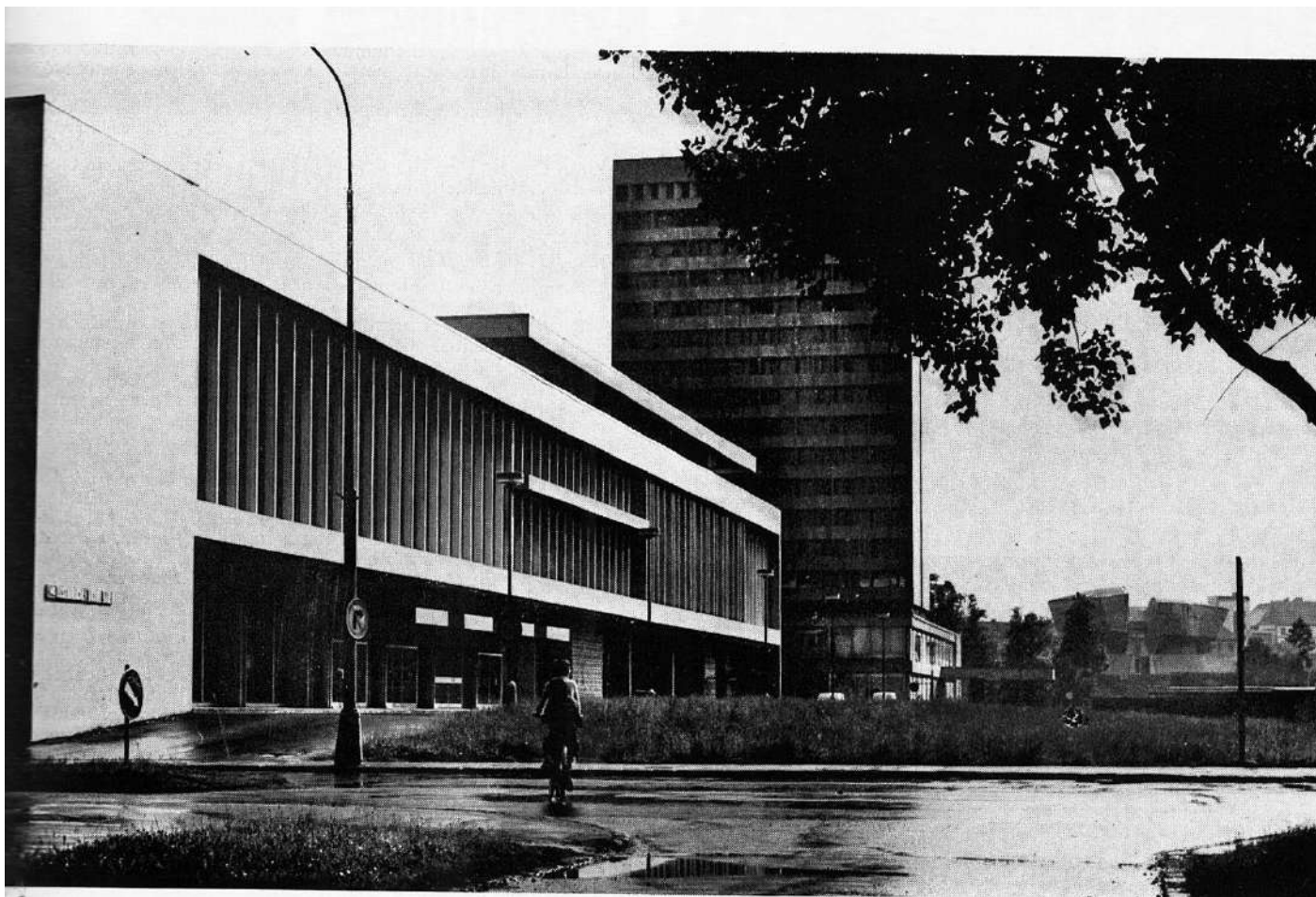
Fig.17 Pohľad na severnú fasádu, archívny záber
