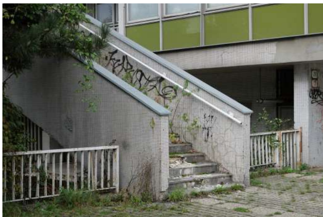
Fig.86 Vstup na rampu
