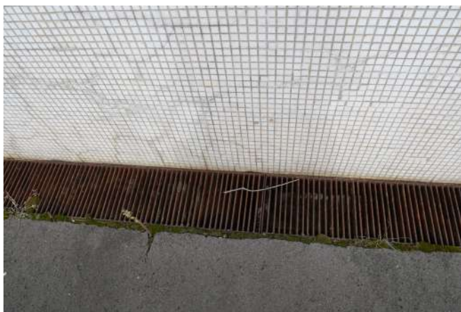
Fig.92 Mreže na odtok vody z rampy
