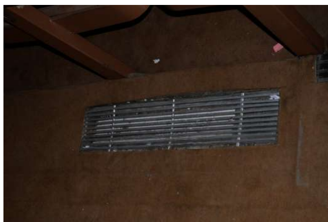
Fig.207 Vzduchotechnika v podlahe medzi sedačkami
