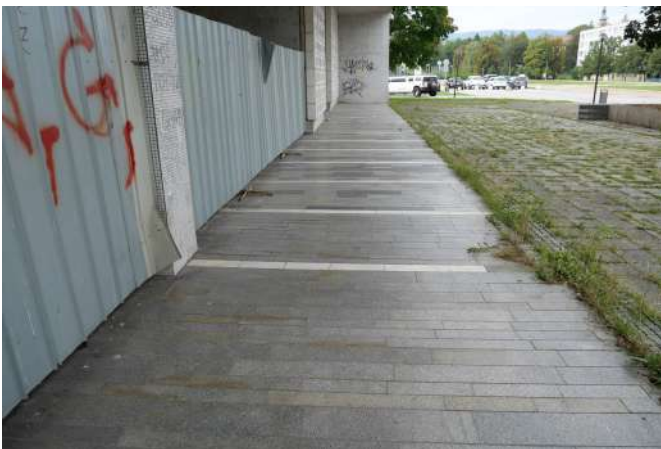
Fig.55 Zakrytý prechod do átria
