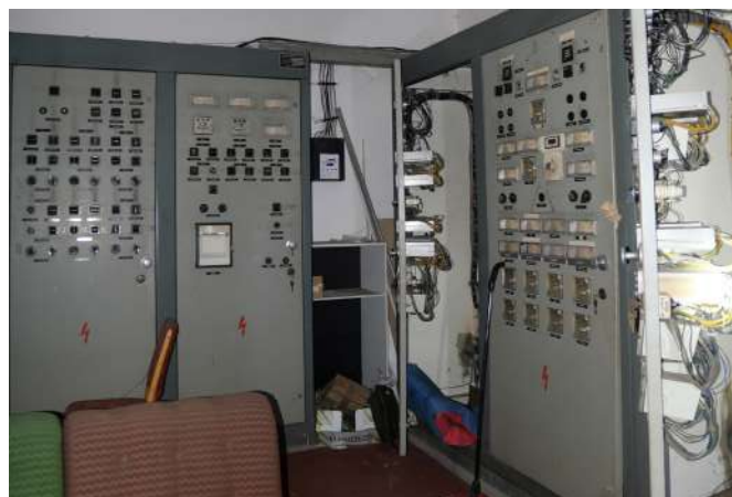
Fig.139 0-41 meranie a deregulovanie, zachované rozvody
