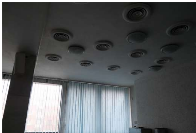
Fig.130 Vetranie reštauračného priestoru, nové osvetlenie
