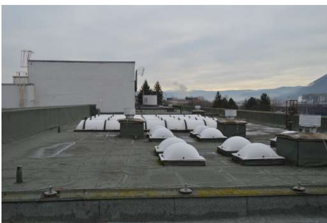
Fig.104 Svetlíky nad baletnou sálou
