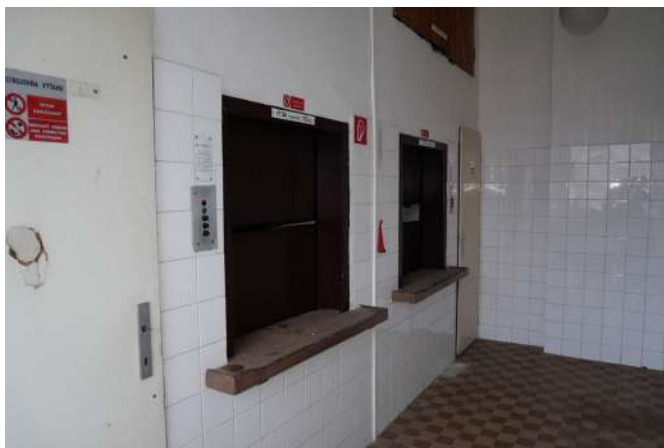
Fig.131 3-4 prípravňa s výťahmi, stále funkčné (01/2024)
