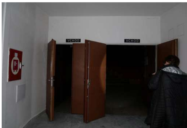
Fig.251 1-85, vstup, čalúnené dvere, pôdodné značenie
