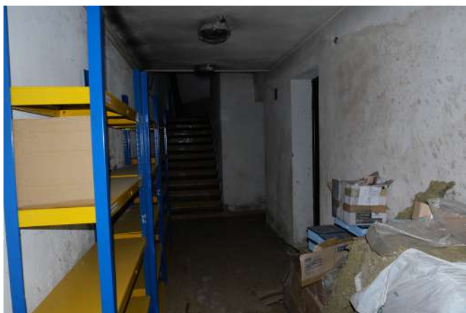
Fig.219 0-84, chodba na 1. NP
