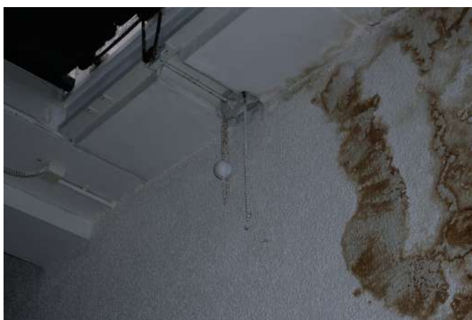
Fig.205 Kladka na mechanické otáčanie tienidiel, vlhkosť
