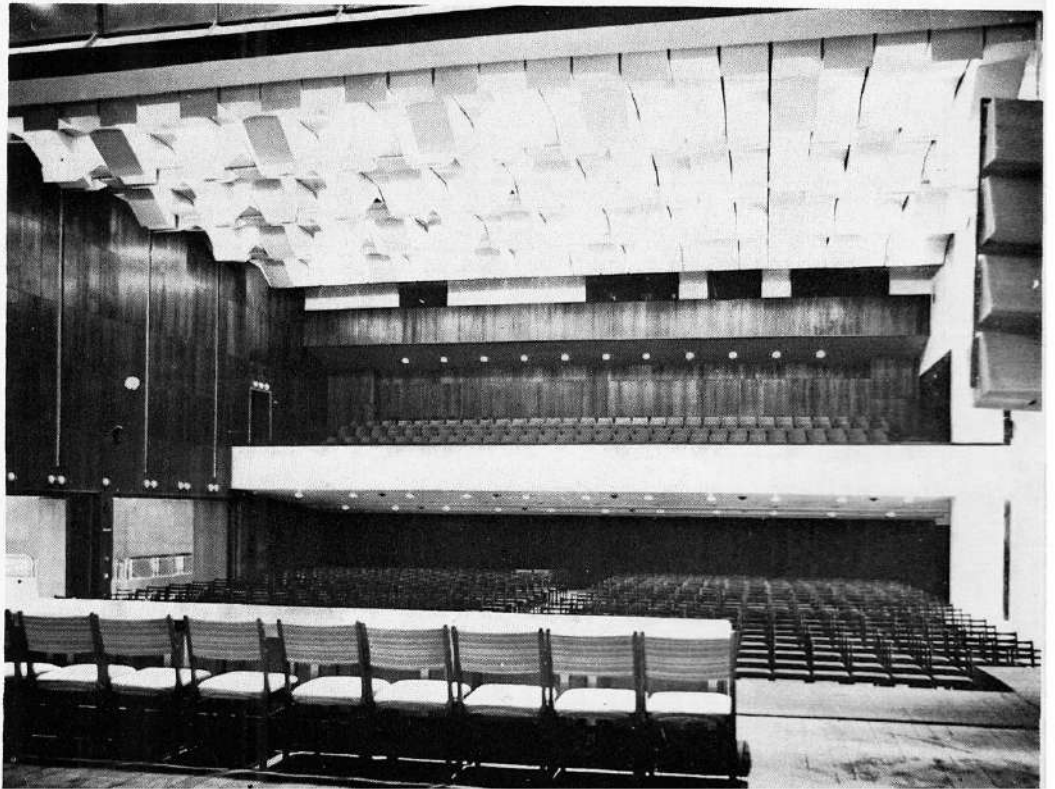
Fig.22 Archívne zábery, fotografie interiéru, článok
