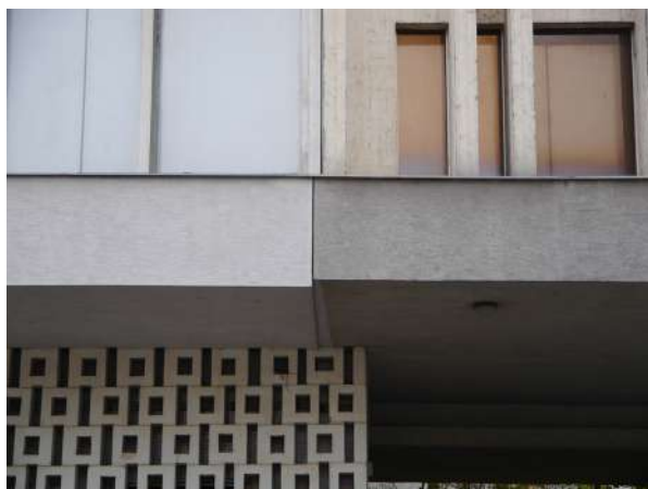
Fig.51 Stret materiálov, dilatačná spára
