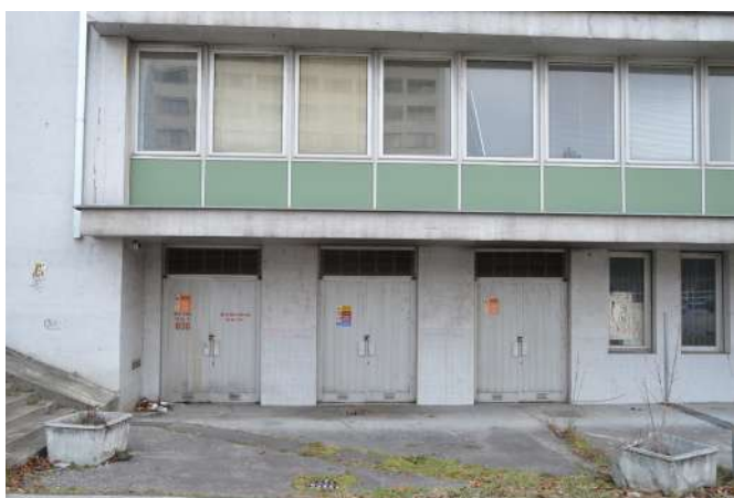
Fig.67 Vstup do trafostanice
