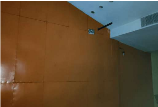
Fig.245 0-74, pôvodné obloženie báb. divadlo a VZT
