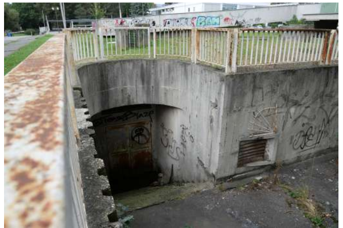
Fig.71 Vstup do bunkra
