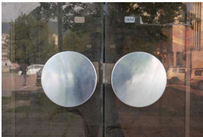
Fig.45 Pohľad kľučku hlavných dverí
