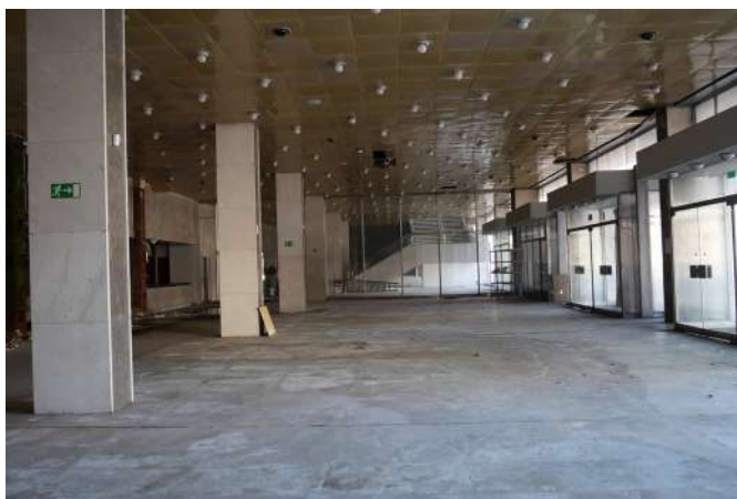
Fig.146 1-25 pohľad skrz obidva vestibuly, estrády aj divadla
