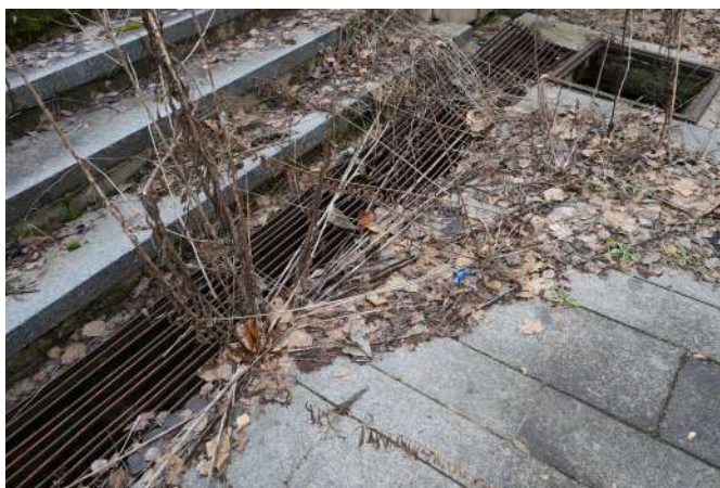
Fig.61 Odvod dažďa v átriu
