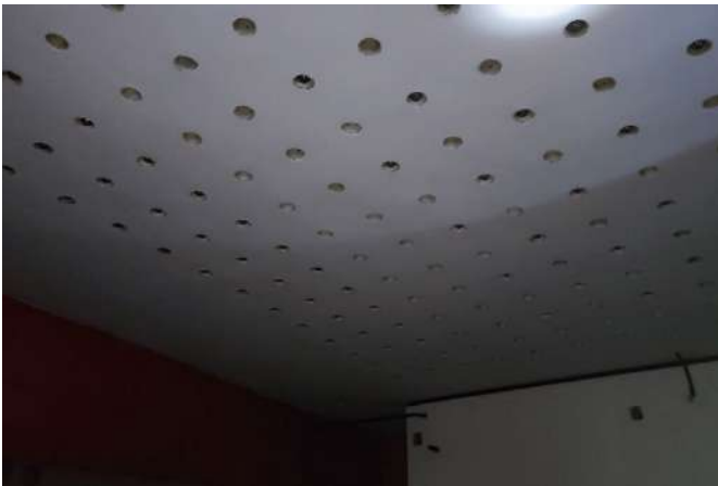
Fig.243 0-74, pôvodný strop so svetlami
