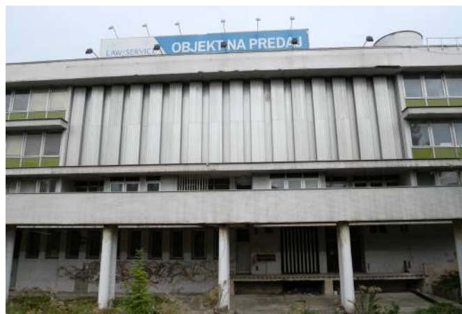
Fig.81 Južná fasáda, rampa a stĺpky
