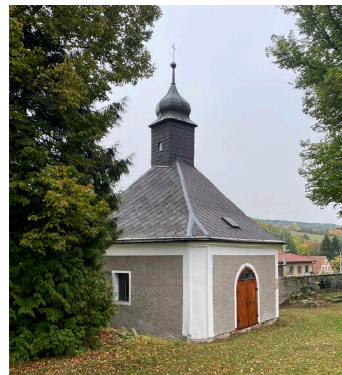
Pohled na kapličku/márnici (vl.foto)
