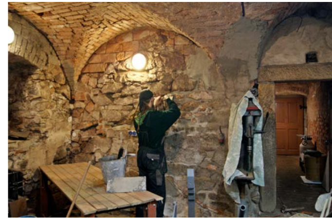
Oprava zdiva v kovárně
