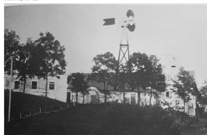
Statek č.p. 263, větrný mlýn sloužící k čerpání vody ze studny (3)
