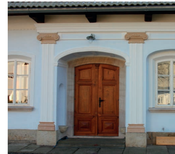
Detail vstupního portálu se šneky, Velký Dřevíč (13)
