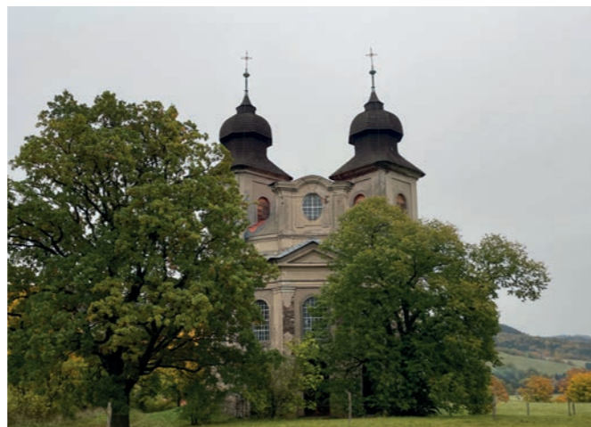
Pohled na kostel (vl. foto)
