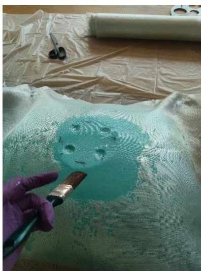
Obrázek 50: Pokládání vrstvy sklovlákna, 2024
