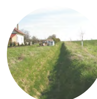
záchytný příkop nad intravilánem obce
