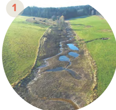
1 rozvolnění koryta potoka doplněná o soustavu tůní
