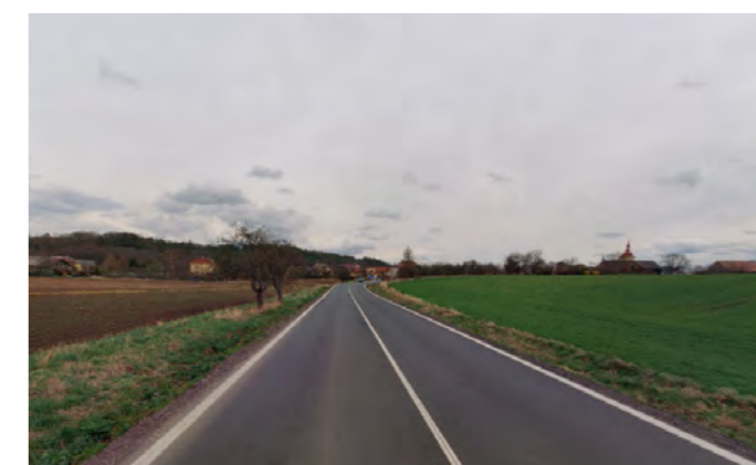
Silnice č. 268 - úsek k Dobré vodě (pohled k obci)
