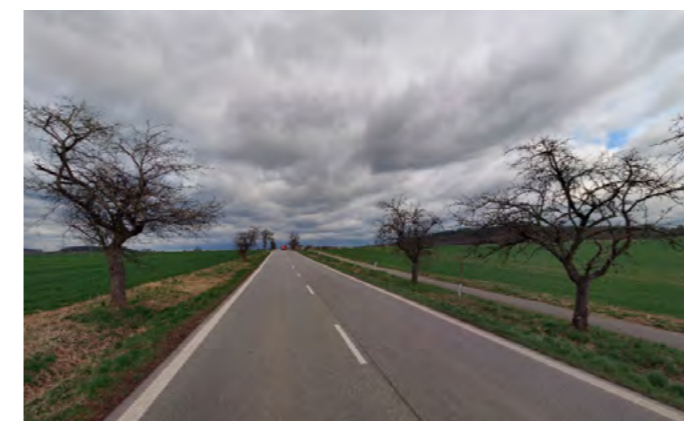
Silnice č. 268 - jižně od obce se sdílenou pěší a cyklo s
