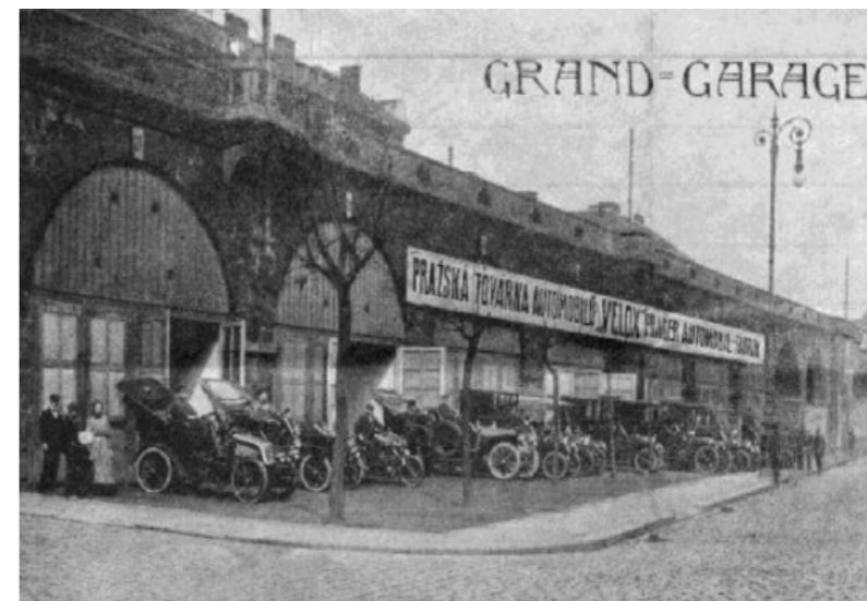
OBR 10 - Garáže Velox v obloucích Negrelliho viaduktu
