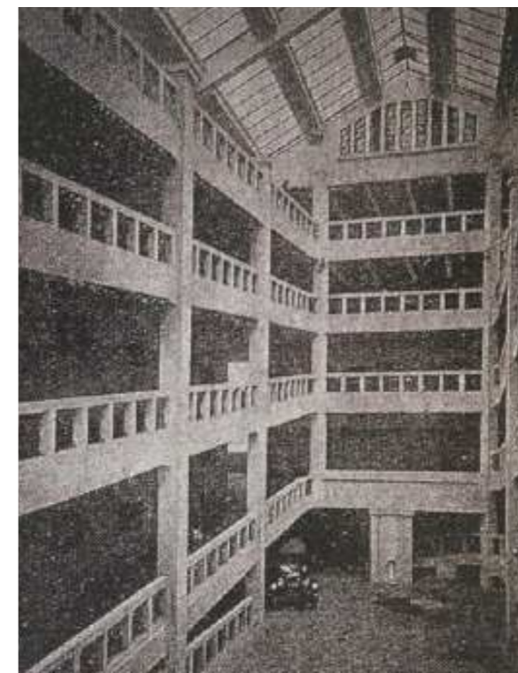
OBR 3 Cyclop Garage, Budapešť (1927)
