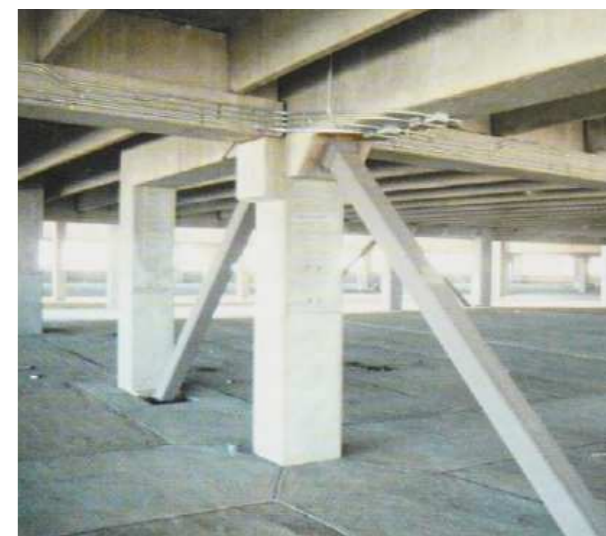
OBR 7 - Mezinárodní letiště, Denver, Kolorádo, (1992) - kombinace oceli a betonu
