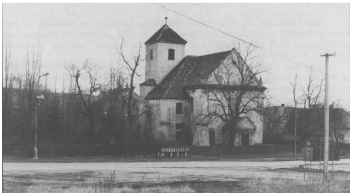
Obr. 43: Kostel Všech svatých v 70. letech 20. století (zdroj: zanikleobce.cz)
