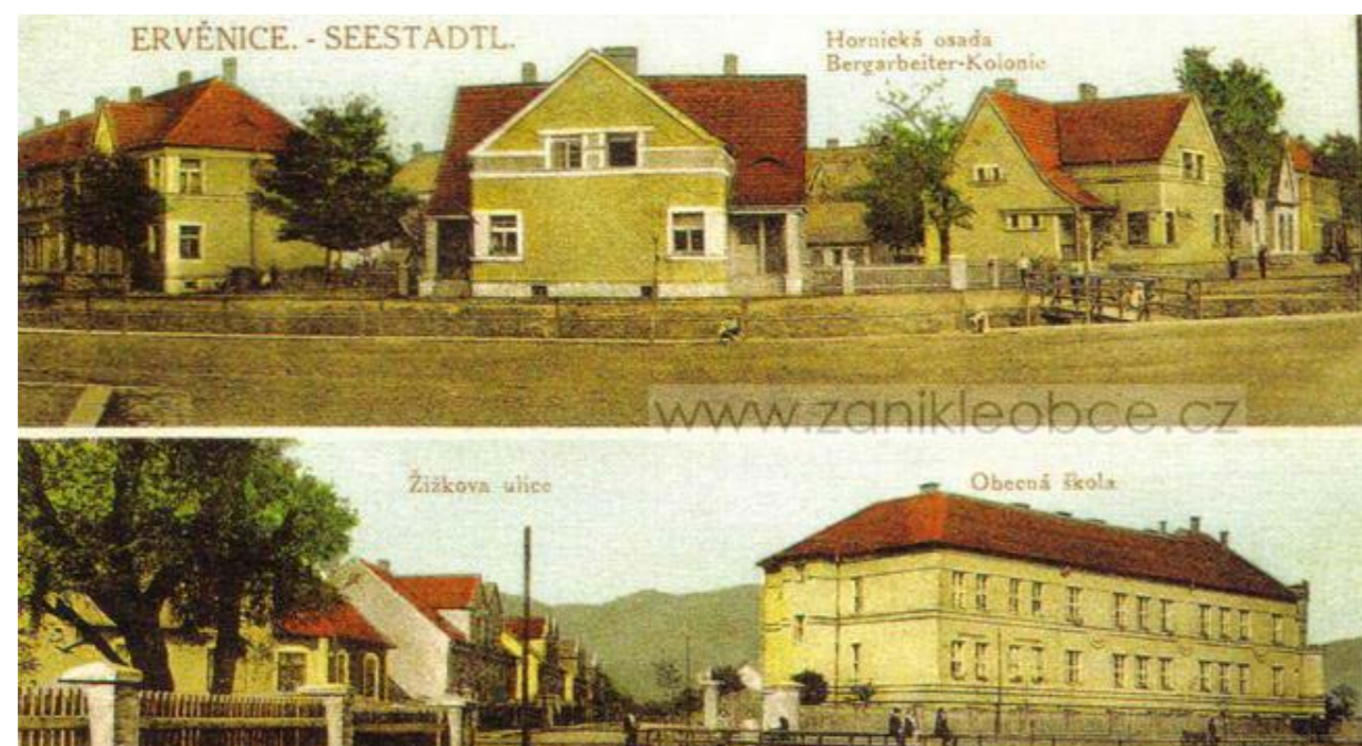
Obr. 56: Škola a hornická osada v Ervěnicích (zdroj: zanikleobce.cz)
