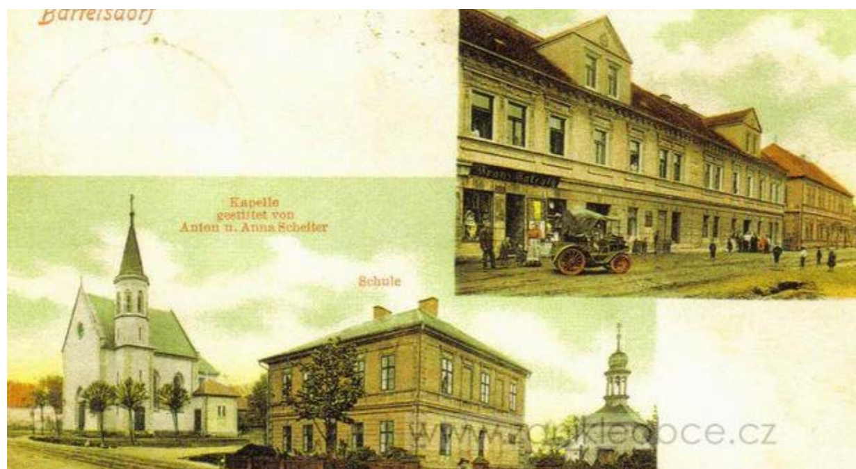
Obr. 79: Kaple a škola v Dřínově - nedatováno (zdroj: zanikleobce.cz)
