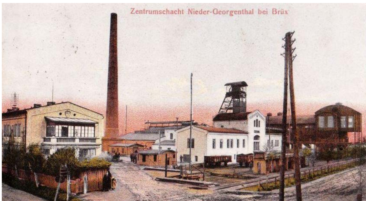
Obr. 127: Důl Centrum v roce 1916 (zdroj: zanikleobce.cz)
