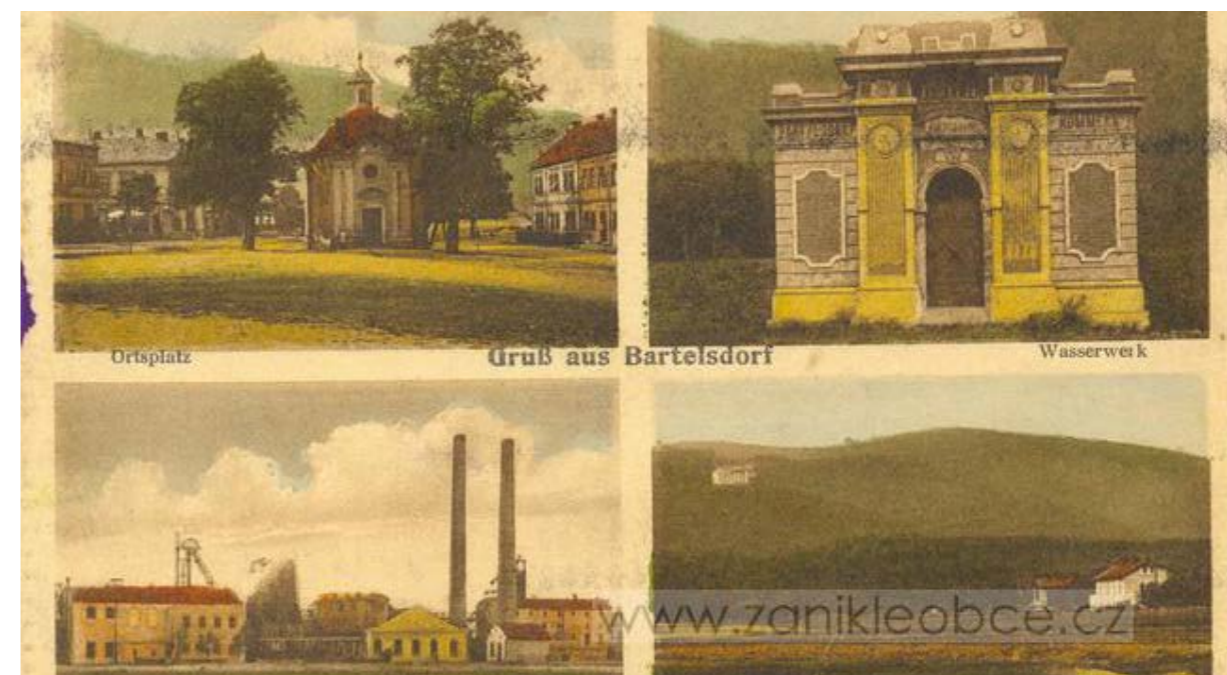
Obr. 81: Náměstí a šachta v Dřínově v roce 1930 (zdroj: zanikleobce.cz)
