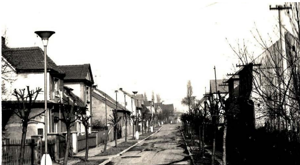
Obr. 75: Ulice v Komořanech - nedatováno (zdroj: zanikleobce.cz)
