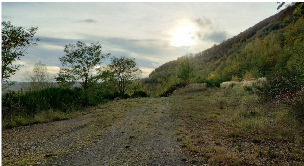
Obr. 14: Pohled z jezeřské strany na ukončení tzv. Chomutovské silnice (zdroj: archiv autora)
