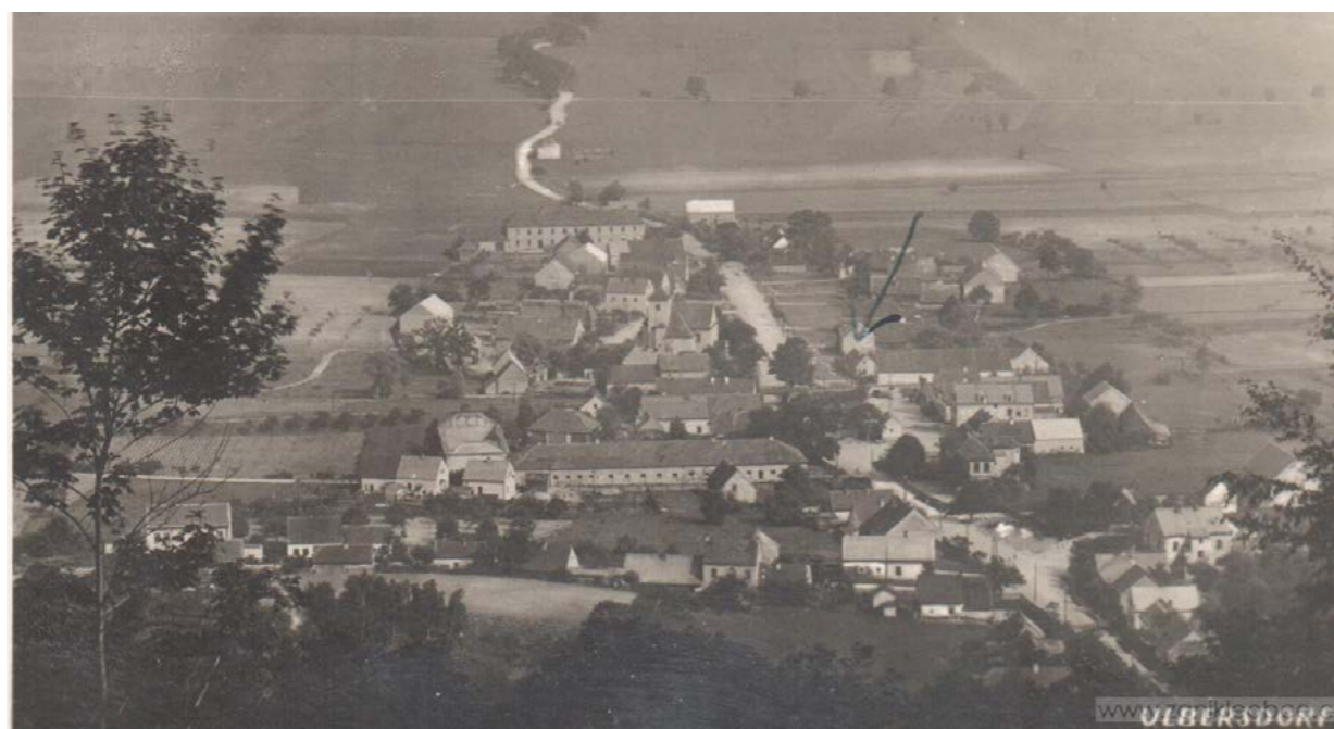
Obr. 40: Celkový pohled na obec směrem od Jezeří z 30. let 20. století (zdroj: zanikleobce.cz)
