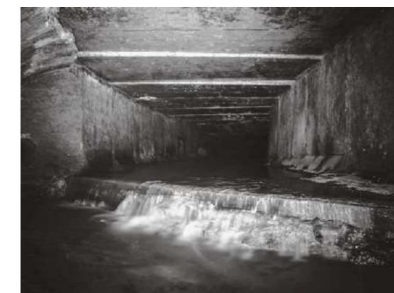
řeka Hlybočyca v kolektoru, současný stav
