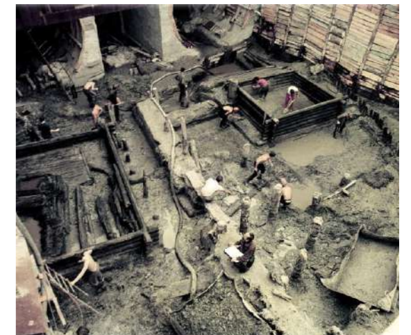
výstavba stanice metra Kontraktová náměstí 1970 rok
