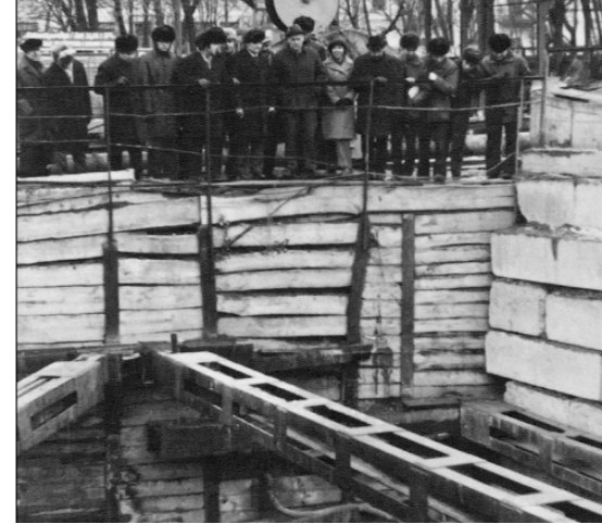
výstavba stanice metra Kontraktová náměstí 1970 rok
