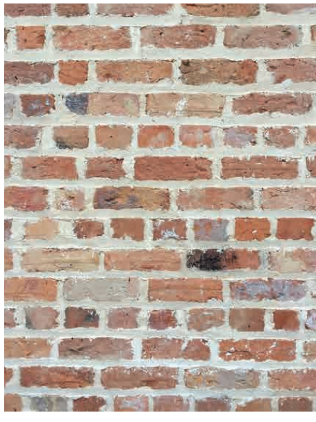
vyspávané původní cihelné zdivo
