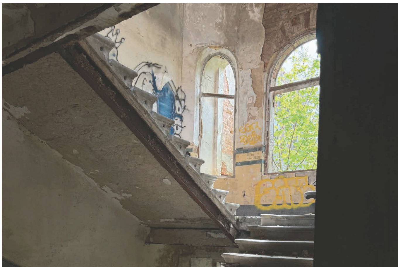
schodiště v hlavní budově
