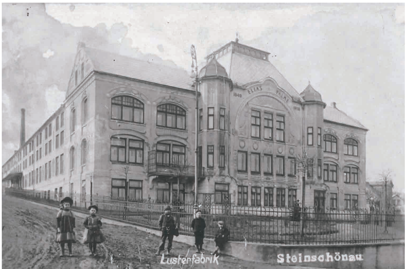
dobová fotografie secesní fasády hlavní budovy
