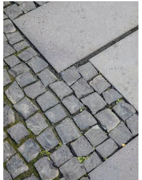
kontrast dlažby na nádvoří
