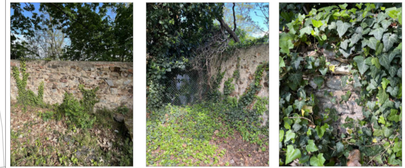
ÚSEK G - OČIŠTĚNÍ A OMÍTNUTÍ ZDIVA ÚSEK H - ODSTRANĚNÍ PLOTU ÚSEK I - ZBOURÁNÍ ZDIVA
