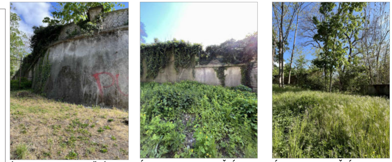
ÚSEK A - ODSTRANĚNÍ BŘEČTANU A OMÍTNUTÍ ZDIVA ÚSEK B - ODSTRANĚNÍ BŘEČTANU A OMÍTNUTÍ ZDIVA ÚSEK C - DOZDĚNÍ A OMÍTNUTÍ ZDIVA
