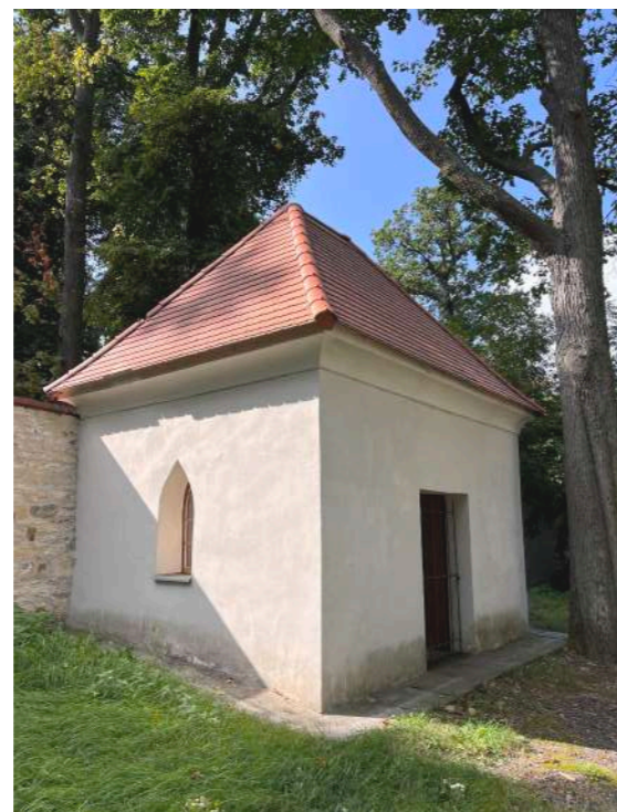
Opravená bývalá márnice hřbitova
