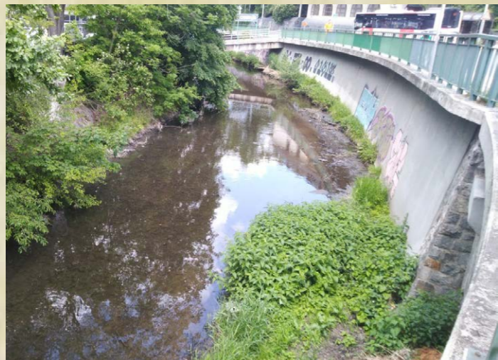
Obr. 29: Zpevněné koryto toku Botiče
