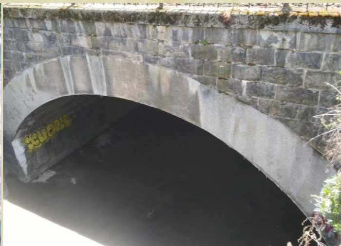
Obr. 30: Zatrubnění Botiče před jeho ústím do Vltavy
