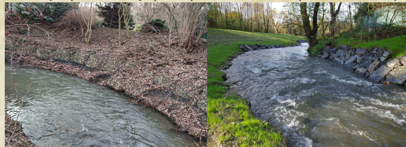
Obr. 40 a 41: Fotografie před a po realizaci revitalizace koryta Botiče v Záběhlicích (Pražská příroda, 2022)
