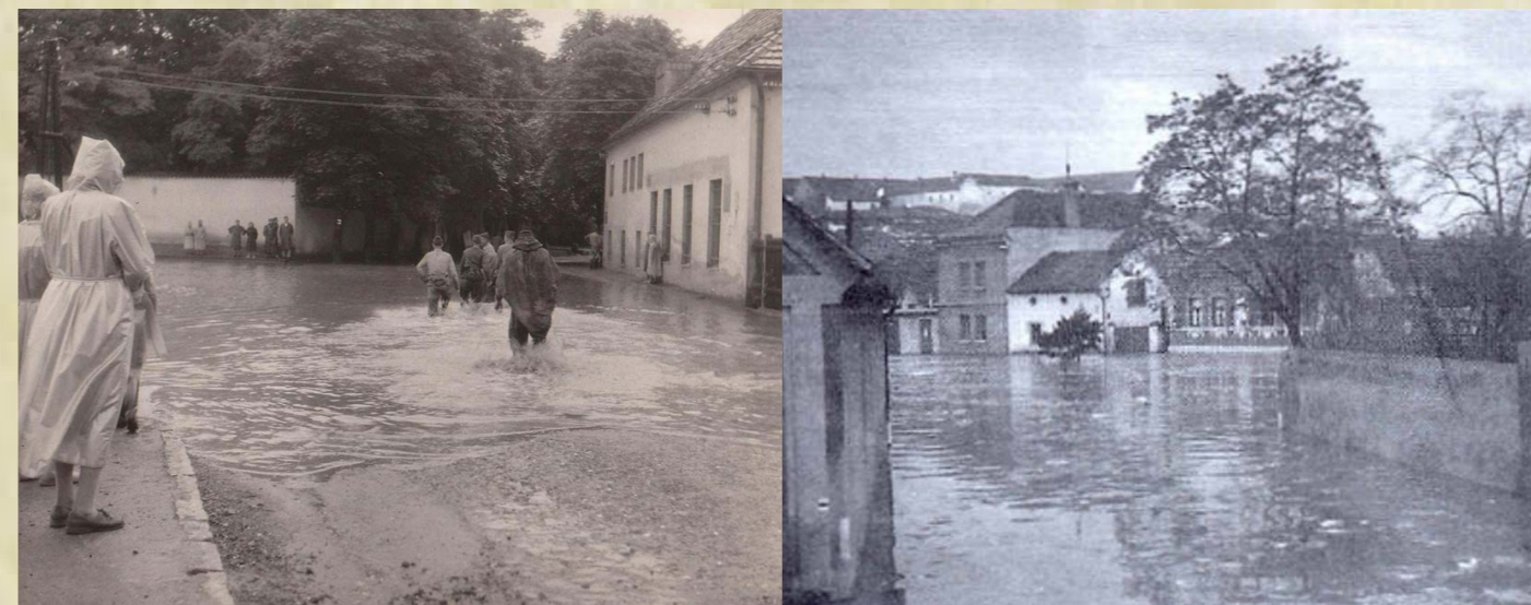
Obr. 37 a 38: Fotografie z povodně v Záběhlicích 4. 7. 1958 (vlevo zdroj Pražská příroda, 2013, vpravo zdroj Lesy hl. m. Prahy)
